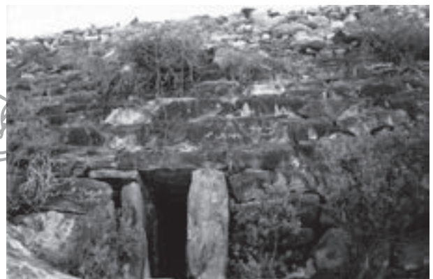
Figure 3 - Barrage du wādī 'Alma.
