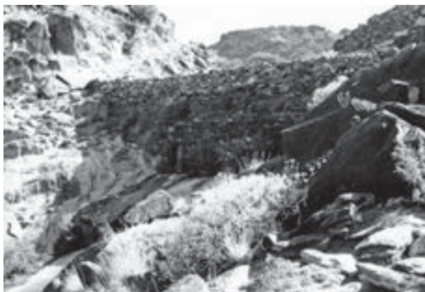
Figure 2 - Barrage du wādī 'Alma.
