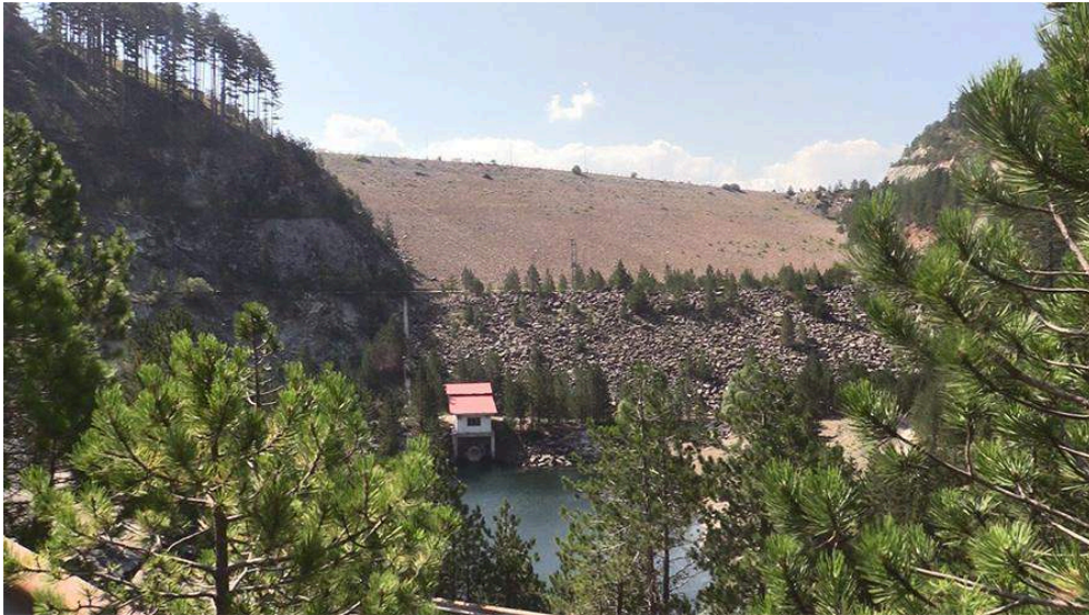
Figure 3. Le barrage du lac des sources de l'Aoos
