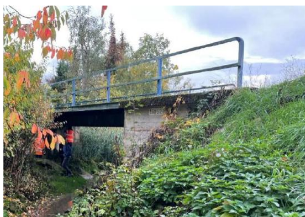
Figure 91 : Km 2,944 (source : MIG GmbH).
