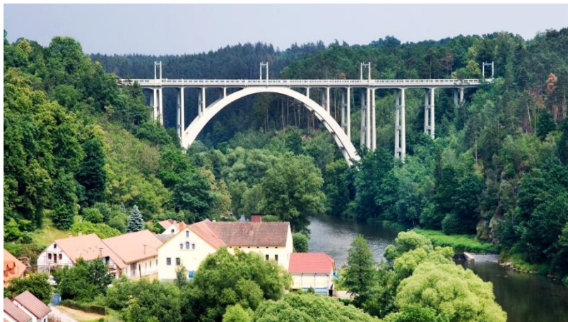
Figure 30 : Le pont « Bechyňská duha » (source : https://budejovice.rozhlas.cz/bechynska-duha-slavi-90-unikatni-most-stavelo-400-delniku-pouhe-dva-roky-7550993 ).
