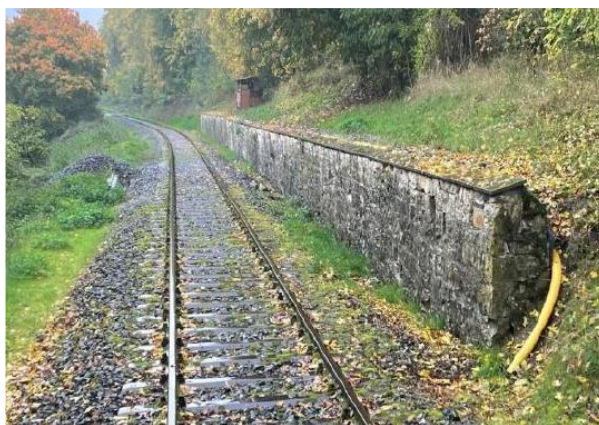
Figure 92 : Km 7,050 – 7,120 (source : MIG GmbH).
