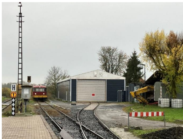
Figure 87 : Le hangar de maintenance (photo : L. Guihéry).
