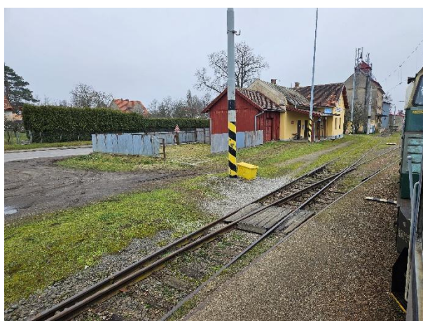
Figure 32 : Voie de fret dans une gare de la Bechyňka (photo : R. Železný).
