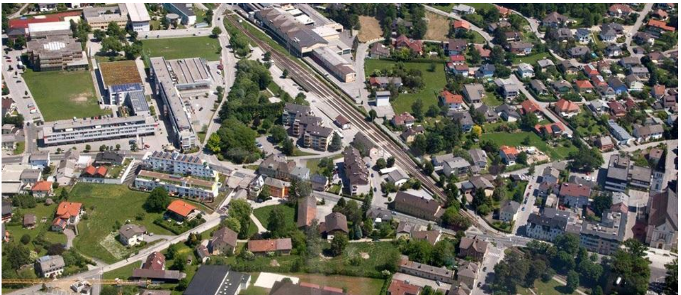
Figure 115 : Nouvelles habitations collectives repérables à proximité imminente de la gare de Oberndorf (source : Wikipédia).
