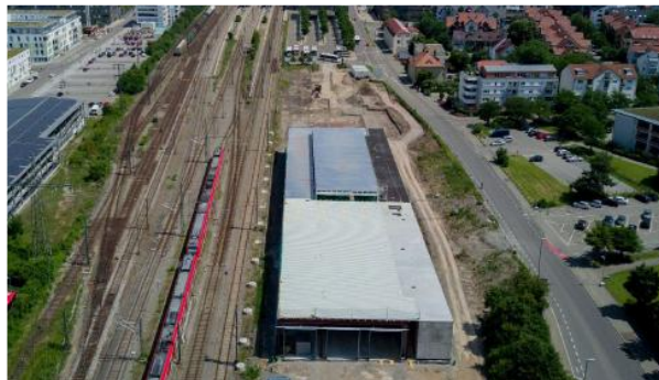
Figure 71 : Le centre de maintenance (source : WEG).
