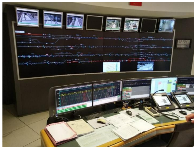
Figure 8 : Commande centralisée de la ligne (photo : R. Železný).
