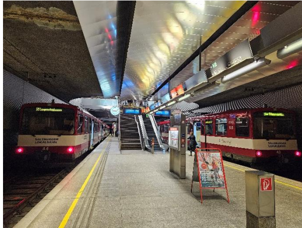
Figure 102 : Point de départ du tronc commun de la ligne, la « Nouvelle gare locale » souterraine en dessous de Salzburg Hbf, ouverte en 1996 (photo : R. Železný).
