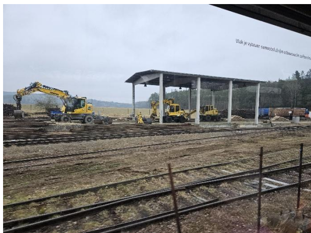
Figure 48 : Espace de fret pour le traitement de bois à Křemže (photo : R. Železný).
