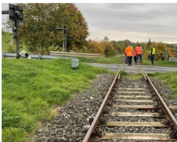
Figure 93 : Un des passages à niveau de la ligne (source : MIG GmbH).
