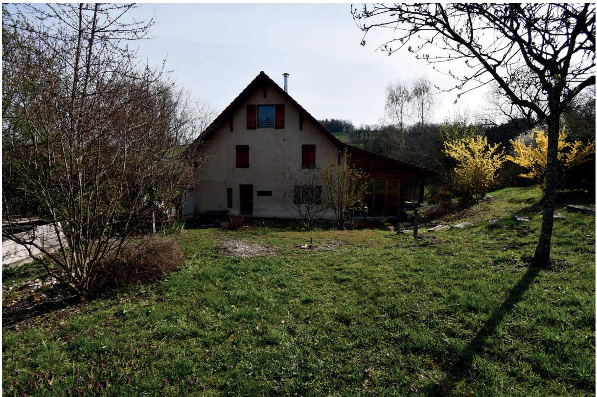
Fig 6 : Les abords de la tour porte avant intervention. Crédit : Equipe de fouille.
