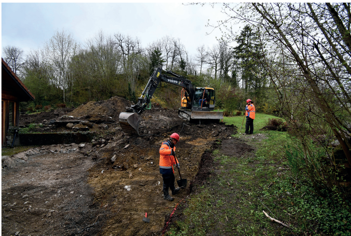
Fig 4 : Terrassements mécaniques en aveugle (sans diagnostic préalable). Crédit : Equipe de fouille.
