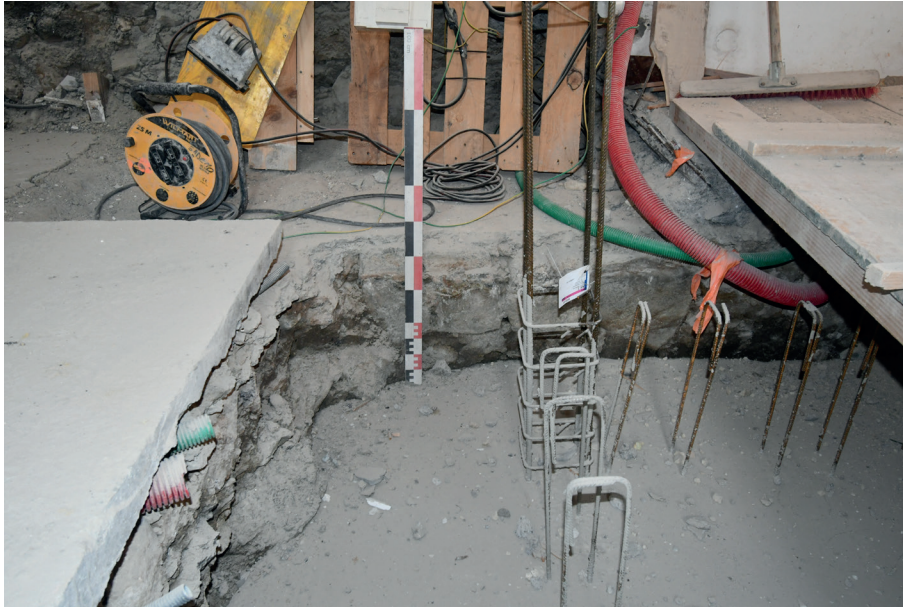
Fig 30 : Vestiges d'une maçonnerie dans la tour pouvant fonctionner avec M 3006. Crédit : Equipe de fouille.
