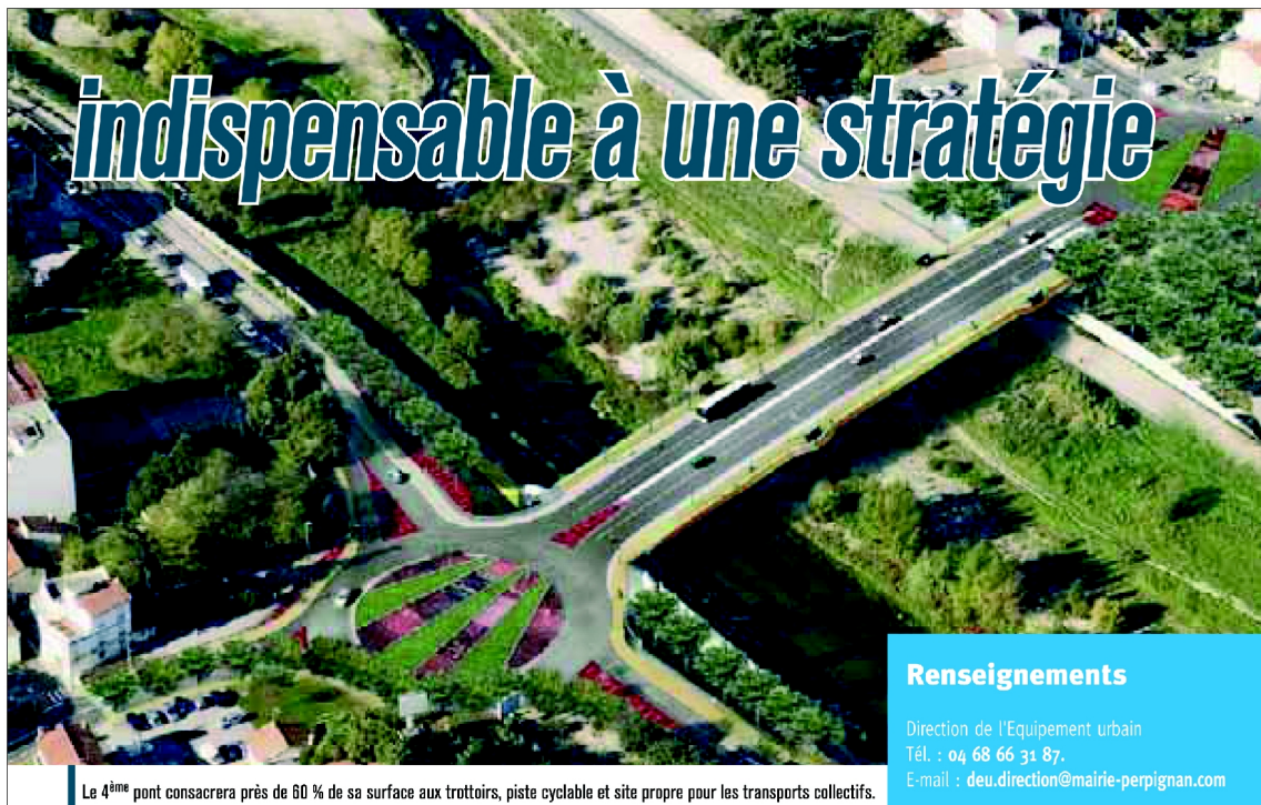
Figure 37 : Photomontage du projet du quatrième pont à Perpignan. Source : Perpignan magazine , n°67, 2007.
