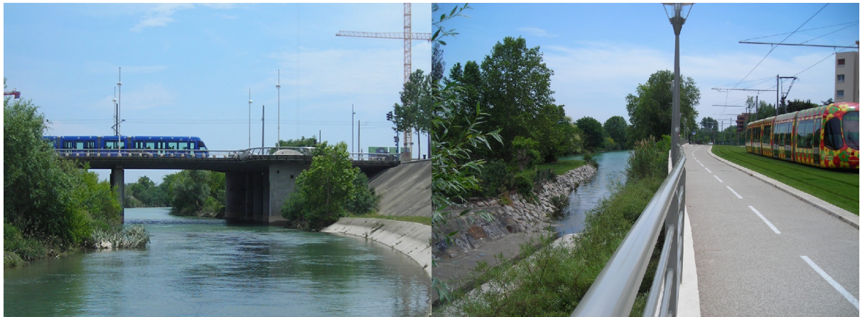
Figure 29 : Passage de deux lignes du tramway, l'une traversant le Lez, l'autre le longeant (photographies : F.Romain, 2007).
