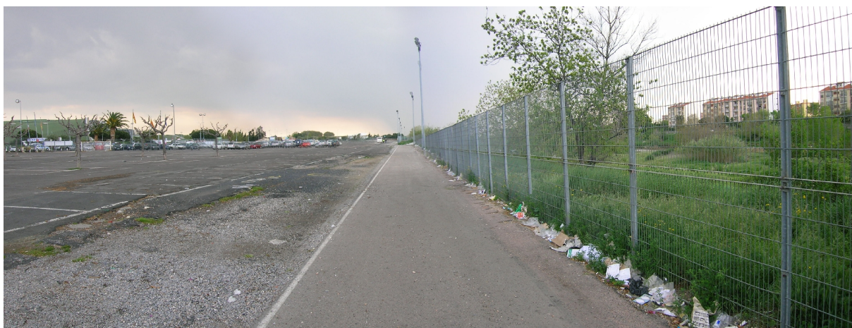
Figure 31 : Absence de mise en relation entre le parc des Expositions et la Têt (photographie: F.Romain, 2007).
