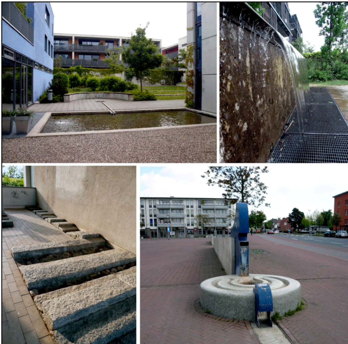
Fig. 36 - Fontaine dans le « cloître » de l'église, cascade dans l'îlot Mikro-Klima, système d'infiltration des eaux de pluie à l'entrée d'un immeuble, fontaine sur la place centrale (Geisler, 2009)
