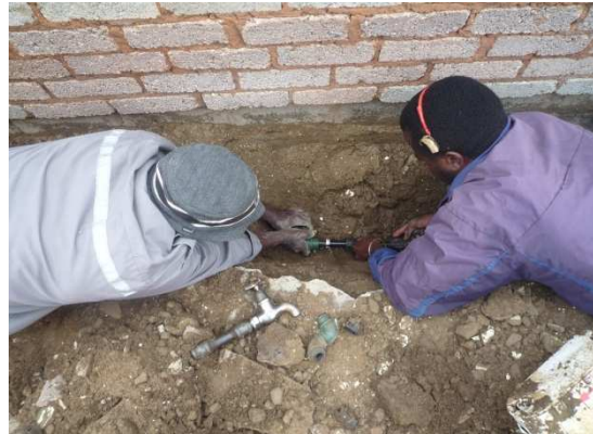
Illustration 27 - Etape 5 : Mise en place du conduit de raccordement artisanal
