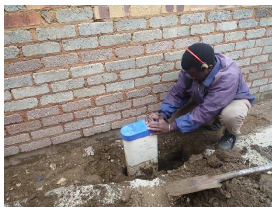
Illustration 22 – Etape 2 : déterrer le compteur
