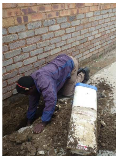
Illustration 23 – Etape 2 : déterrer le compteur
