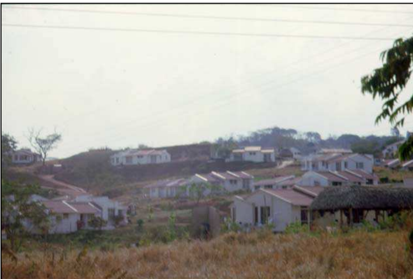
Vue 15 - Yopal. Colina Campestre. Quartier aisé construit à partir de 1994 sur une colline à l'extérieur du périmètre urbain, et auto- approvisionné en services domestiques
