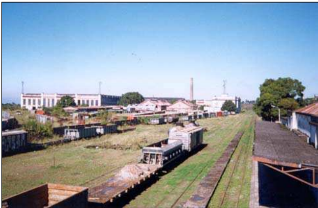
Vue 17 - Anciens ateliers de réparation ferroviaire (Tafi Viejo)
