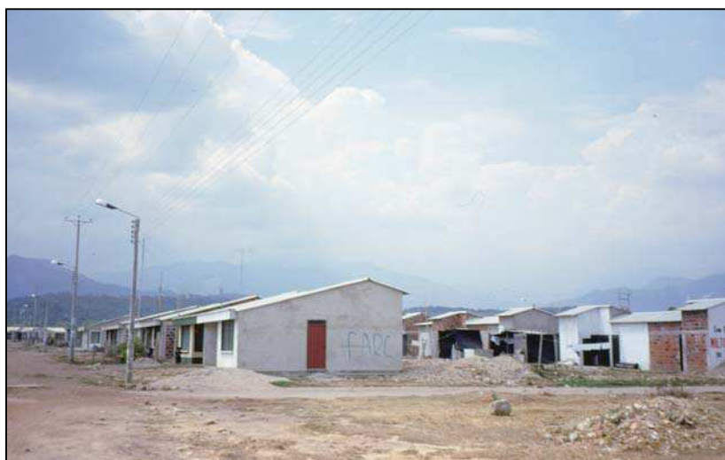
Vue 7 - Tauramena. Ensemble résidentiel destiné aux personnels d'éducation. Le graffiti "FARC" sur la première maison rappelle l'importance du conflit armé dans la région
