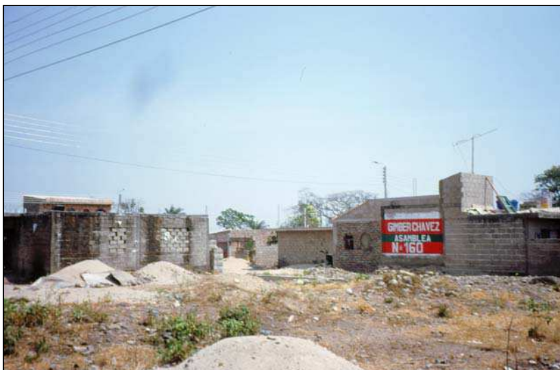
Vue 11 -Yopal. El Raudal , quartier populaire en cours de construction. La publicité électorale rappelle ici le lien étroit qui existe entre clientélisme et urbanisation
