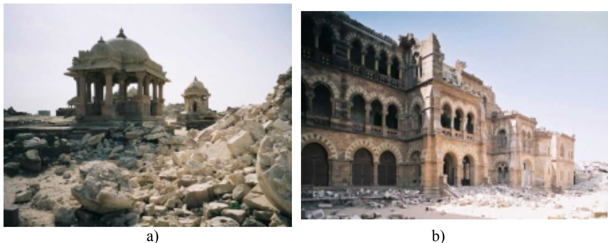
Figure 4.18 Destruction totale du temple Rao Lakhaji Chhatri (a) et partielle du palais Darbargarh (b), suite au séisme de Bhuj (source : UNESCO, 2001).
