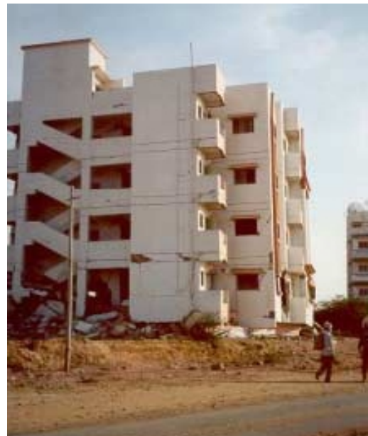
Figure 4.14 Maisons en maçonnerie, très vulnérables face aux séismes (source : Université de Roorkee, Inde)
