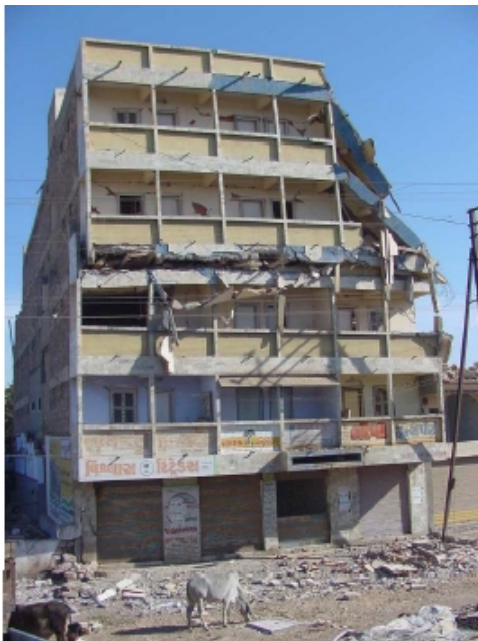
Figure 4.15 Bâtiment en cadres en béton armé, situé à Bhuj, endommagé suite au séisme de 2001 par la ruine classique d'un étage intermédiaire (a) et du rez-de-chaussée (b) (source : EERI, 2001).
