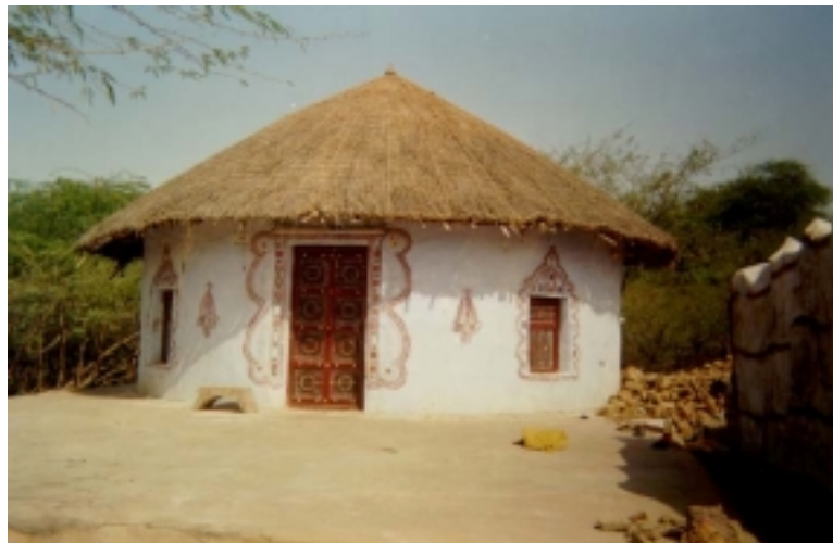
Figure 4.17 Construction traditionnelle de type « bhonga », spécifique à la région de Gujarat (source : www.world-housing.net )
