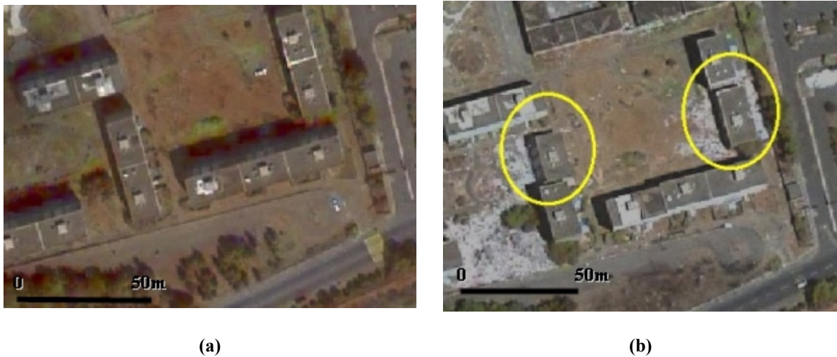
Figure 4.41 Exemple de dommage important à Boumerdes. On distingue les bâtiments à l'intérieur des cercles jaunes comme endommagés mais pas complètement effondrés. L'image prise avant le séisme (a), et celle acquise deux jours après (b) (source image : DigitalGlobe).
