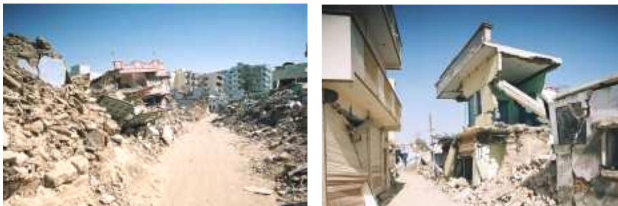
Figure 4. 28 Le centre historique de la ville de Bhuj après le séisme du janvier 2001 (source : UNESCO, 2001).
