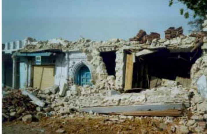
Figure 4.14 Maisons en maçonnerie, très vulnérables face aux séismes (source : Université de Roorkee, Inde)
