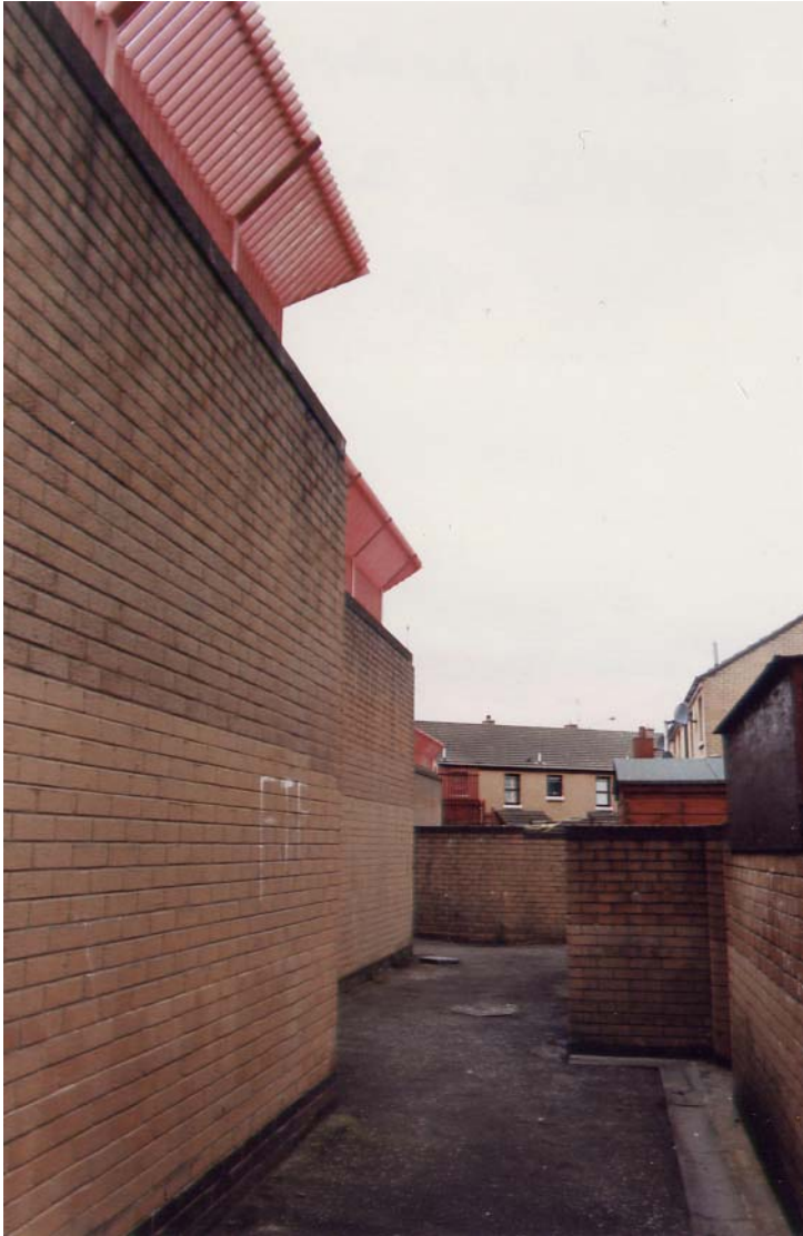
Figure 81 : Mur de sécurité, vue de Clandeboye Gardens (4 juin 2001)
