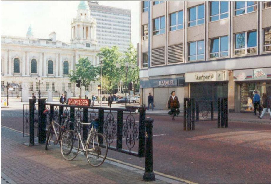
Figure 33 : Barrières ornementées du centre ville, Donegall Place. A l'arrière plan, l'Hôtel de Ville (mai 1998)
