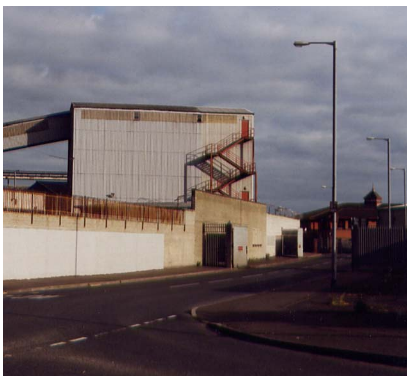
Figure 41 : Installation industrielle et deux portails de Northumberland Street (4 juin 2001)
