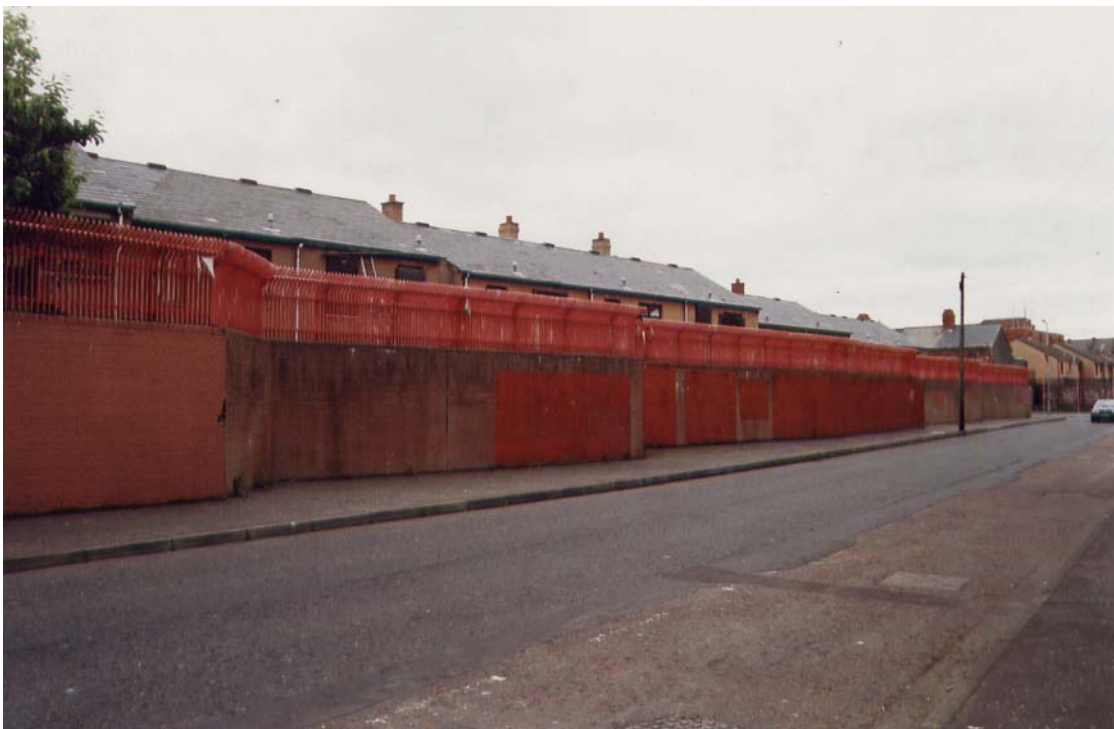
Figure 89 : Bryson Street, mur de sécurité (3 juin 2001)
