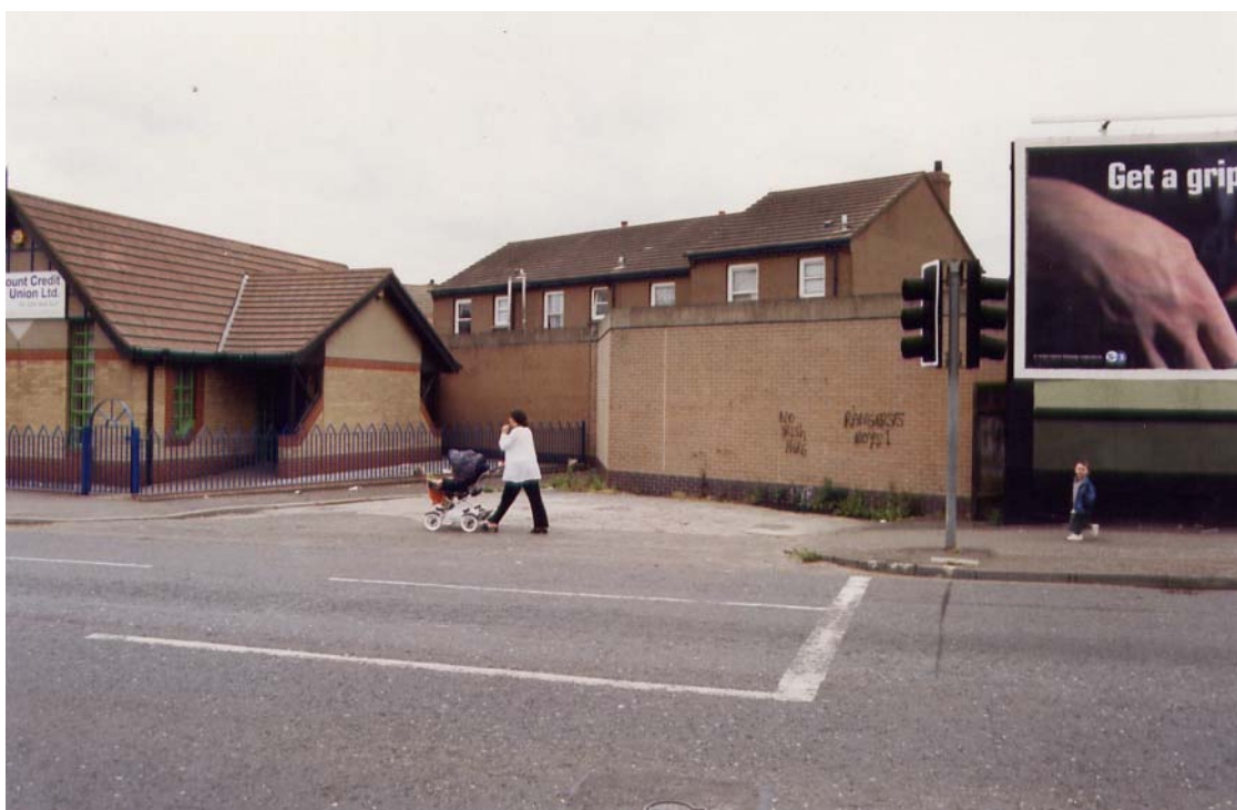
Figure 83 : Mur de sécurité, vue de Mountpottinger Road (4 juin 2001)
