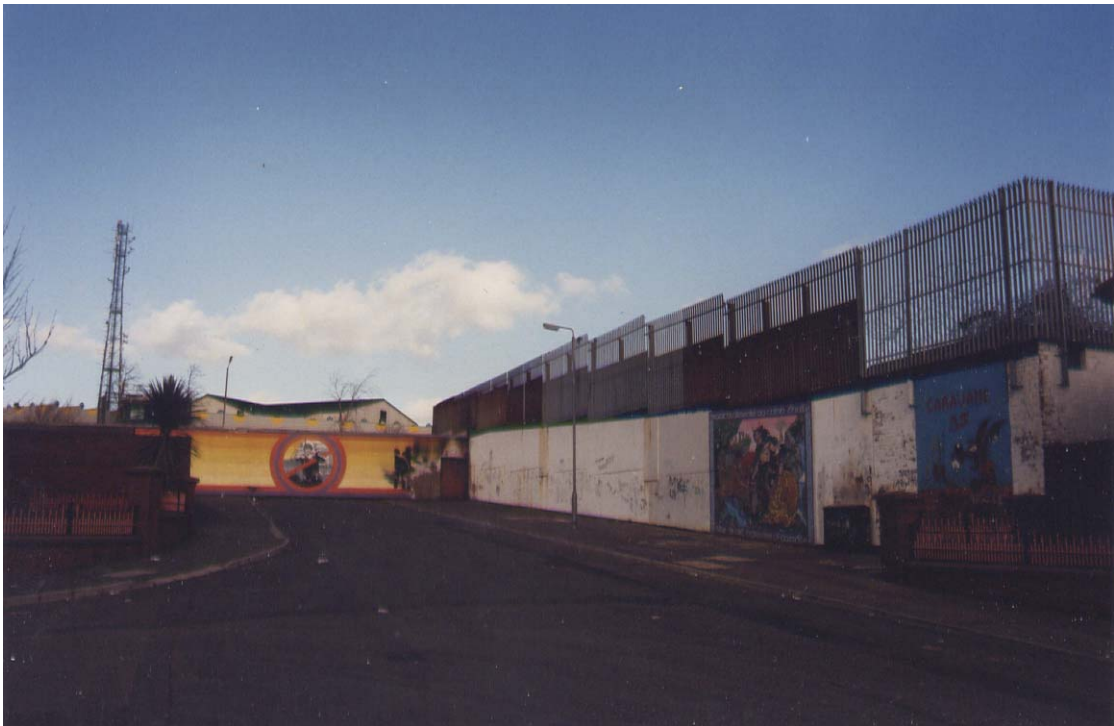
Figure 126 : Mur de sécurité, vu de Springhill Avenue (3 mars 2000)
