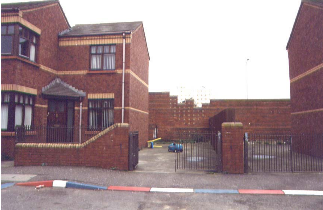
Figure 104 : Peaceline , Crumlin Road, Woodvale, vue de l'intérieur du quartier (13 mars 2000)
