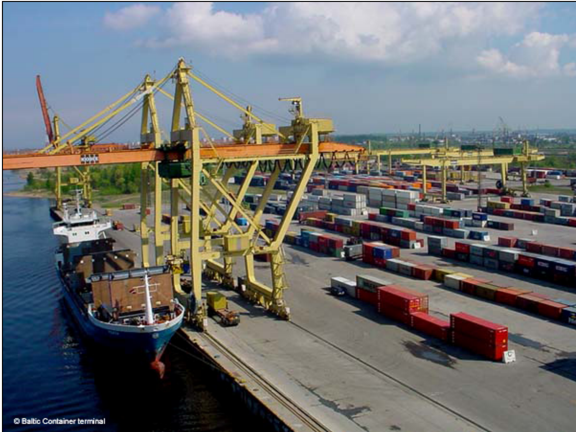
Figure 37 : Le principal terminal pour conteneurs de Riga : Baltic Container Terminal
