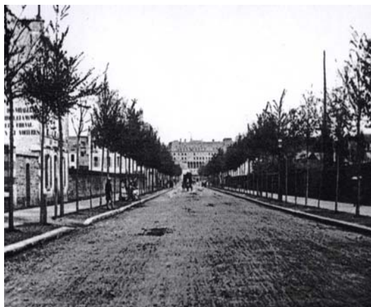
Photo 25- Avenue de la Gare, Rennes, 1895
