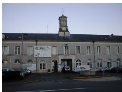
Photo 7- Hôpital Bretonneau, Tours
