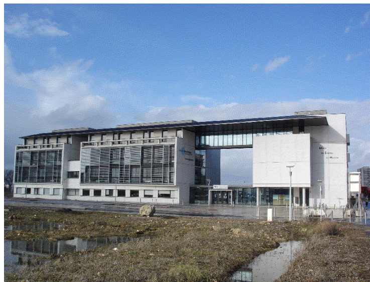
Figure 46 : L'habitation contemporaine de la Maison des Sciences de l'Homme et du pôle Aménagement de l'École Polytechnique de l'Université de Tours.
