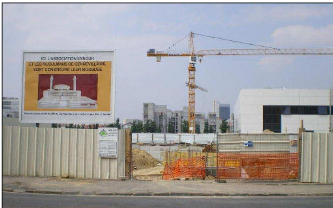
Réalisation : A. Dumont, 2007.
