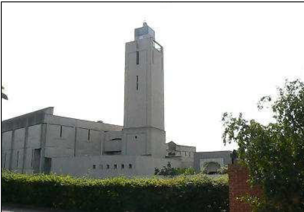
Photo 10 : La mosquée d'Evry, vue du square des Champs Elysées
