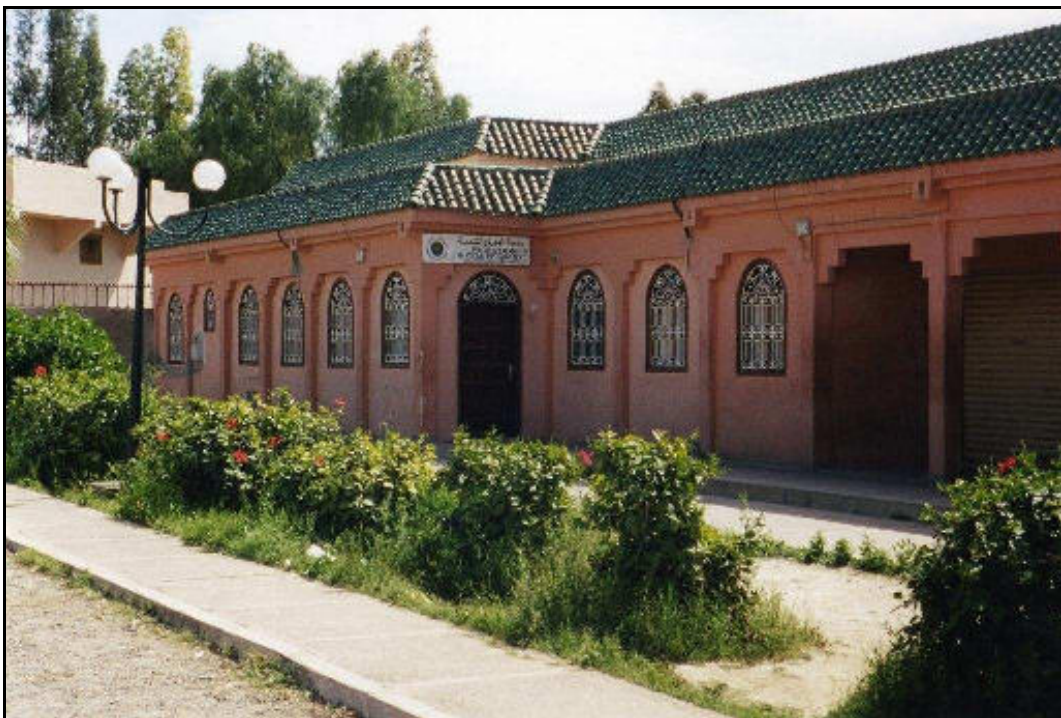
Réalisation : A. Dumont, 2003.
