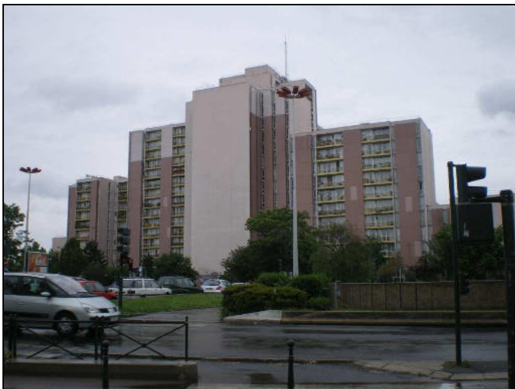
Réalisation : A. Dumont, 2007.
