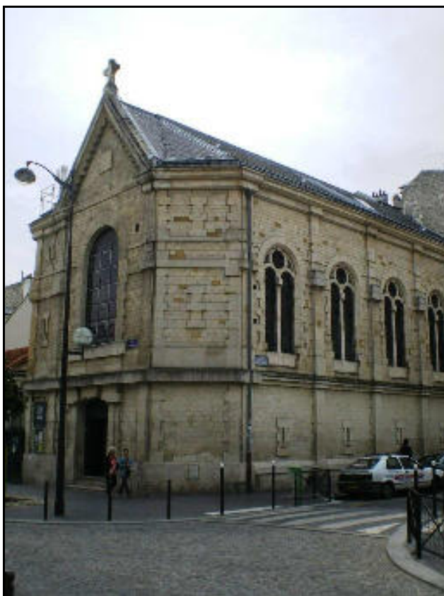
Réalisation : A. Dumont, 2007.
