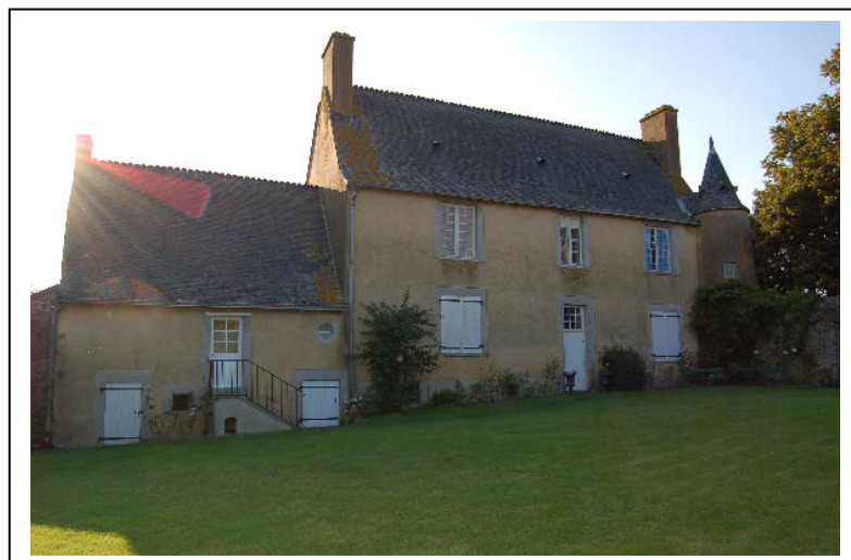
La chapelle et le logis prieural de Bazougers
