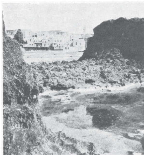
19.19. Mur intercalaire vu du point 26 sur la fig. 19.15 (POIDEBARD et LAUFFRAY, 1951).
