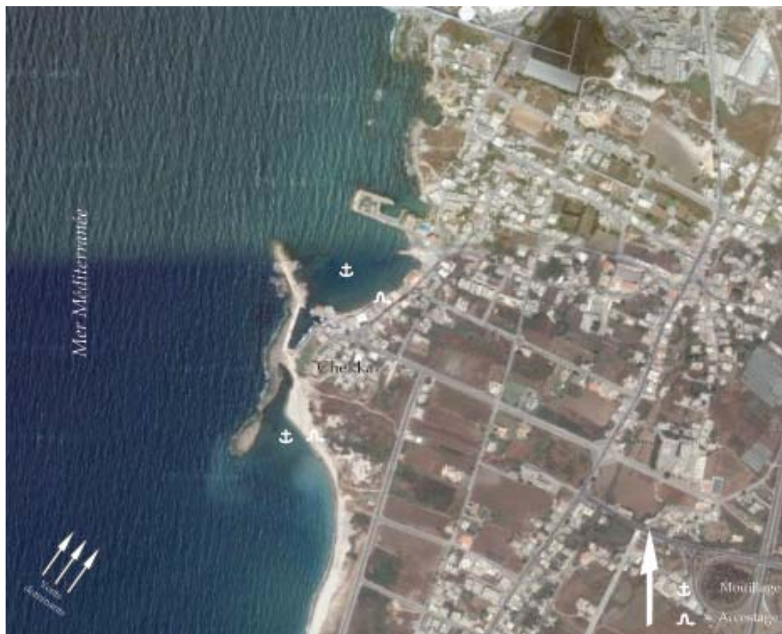
14.02. Le site portuaire de Chekka (détail de la fig. 14.01).
