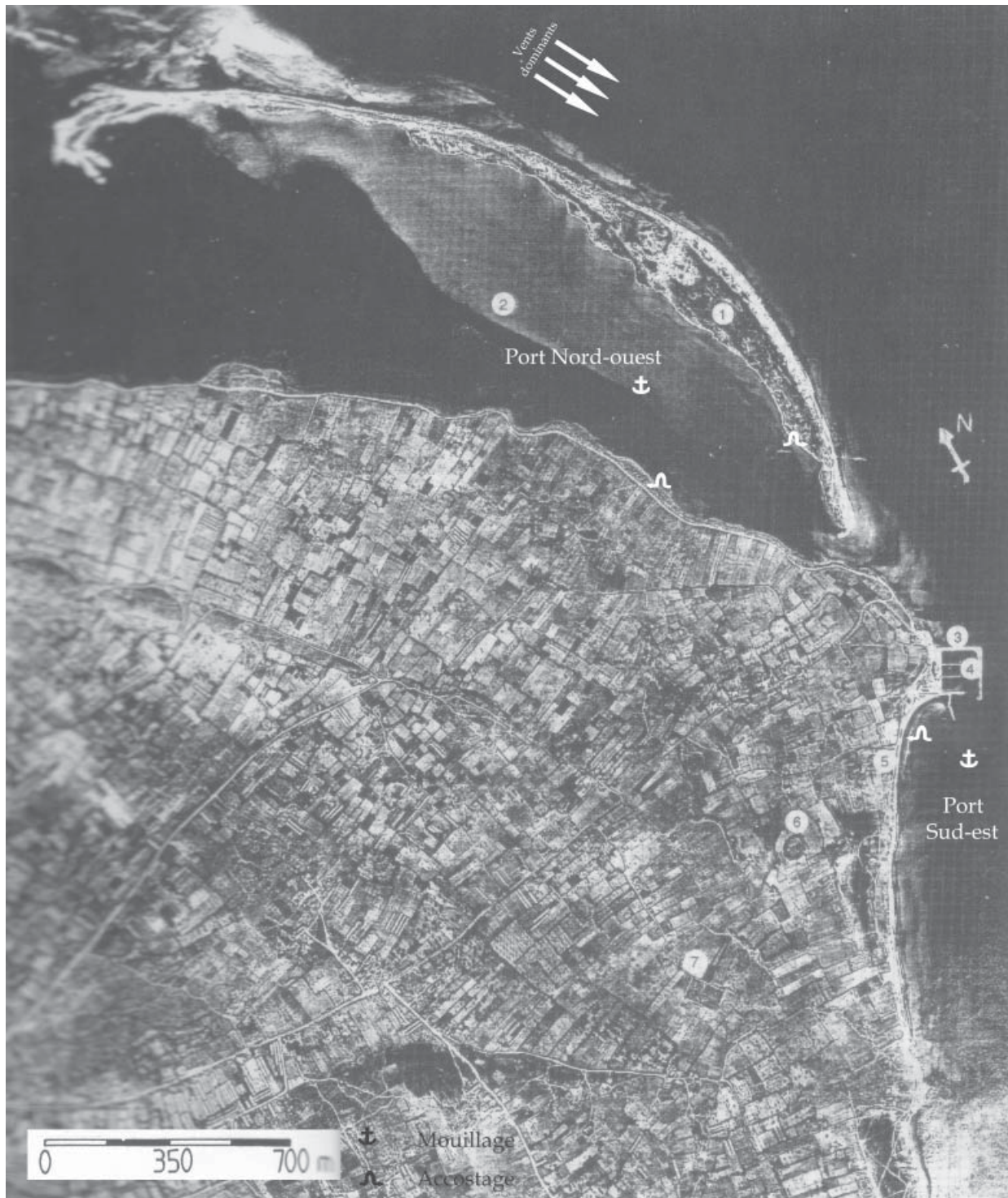
67.01. Vue aérienne verticale du site de l'antique Thapsus au Ras Dimass (YOUNES, 1999a). 1. Île basse et sablonneuse. 2. Haut-fonds. 3. Partie du grand môle réutilisée dans l'aménagement du port actuel. 4. Port actuel. 5. Forteresse. 6. Amphithéâtre. 7. Grands réservoirs publics.
