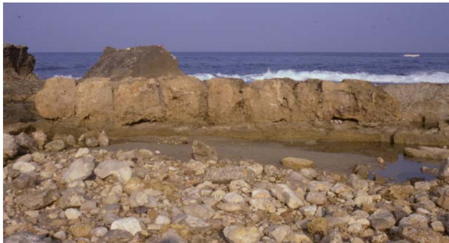
19.17. Vestiges construits du mur de mer de la languette rocheuse en 2003.
