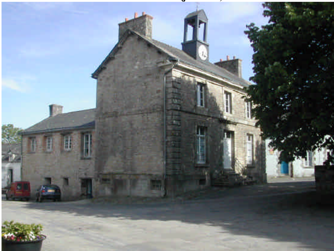
Bâtiment actuel (juin 2004)
