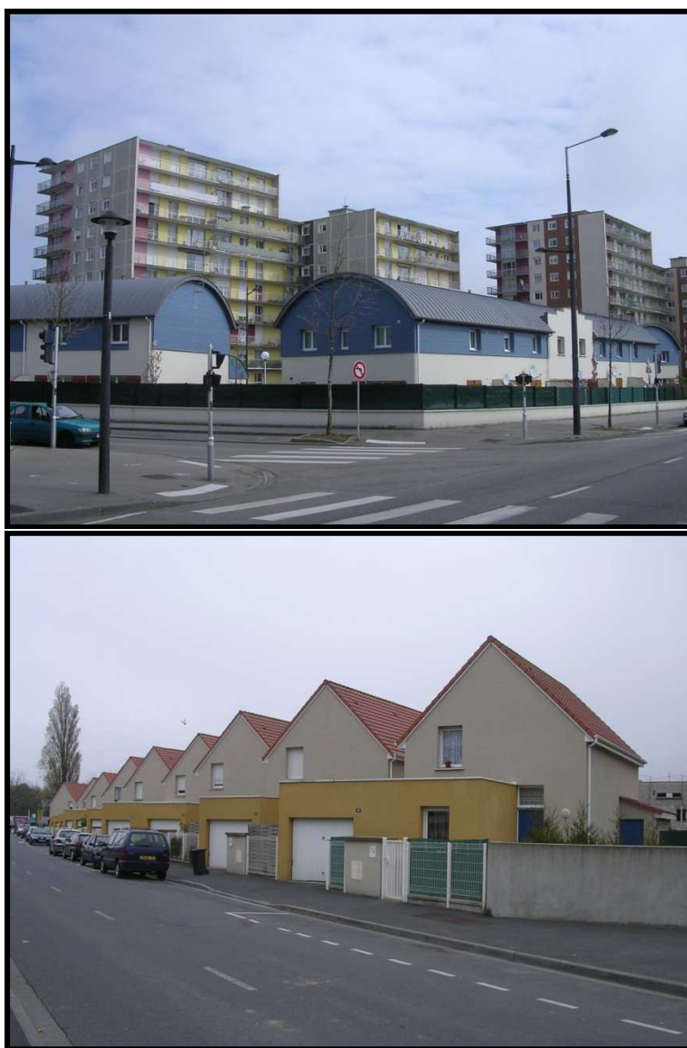
PHOTOGRAPHIES 4.12 et 4.13 : Habitat individuel au Mont-Gaillard (haut) et à la Mare-rouge(bas)
