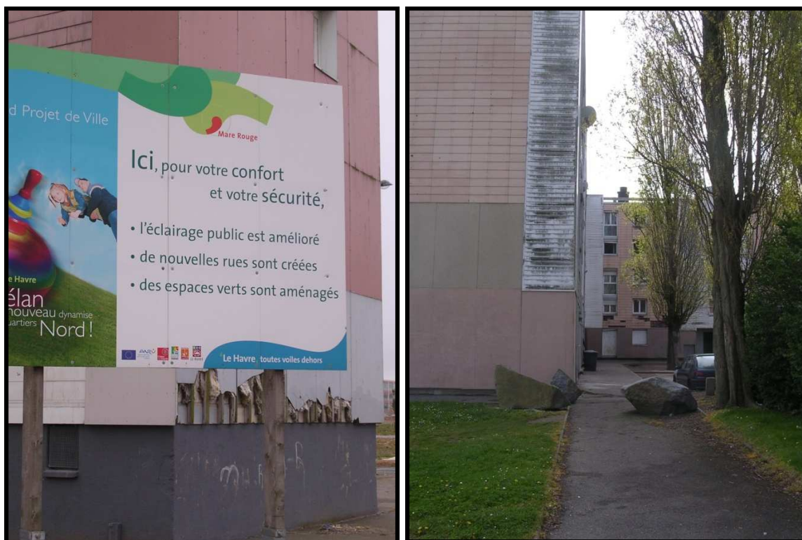
PHOTOGRAPHIES 4.06 et 4.07 : Habitat dégradé et occupé en attente de rénovation
