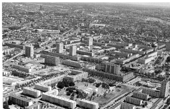
Figure 3.46 : ZUP de Bellevue à l'Ouest de Nantes [ARDEPA 1991]
