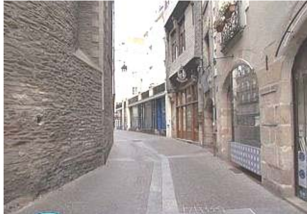
Figure 3.91 : Ruisseau d'évacuation des eaux en surface ; rue Ste Croix (vue actuelle) 130
