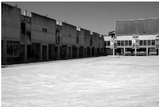
[Le bâtiment de la Mairie]
