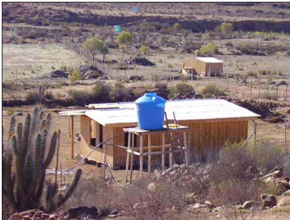
Photo 13 : Lots séparés de la communauté agricole Higuieritas Unidas et devenus des « parcelles d'agrément » individuelles, destinées à l'habitat et au jardinage si les propriétaires peuvent avoir accès à l'eau, ce qui n'est pas visible ici. Noter la construction légère sur le plan conventionnel des habitations rurales du Limarí et le réservoir d'eau pour l'alimentation domestique.
