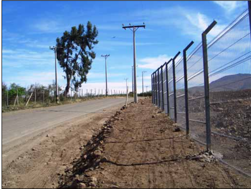
Photo 20 : A droite, une coûteuse clôture moderne délimite la propriété d'une société anonyme de production et de commercialisation. A gauche, clôture plus traditionnelle (maille de fil de fer sur poteaux d'eucalyptus) sur la propriété d'un agriculteur moyen, semi-modernisé.
