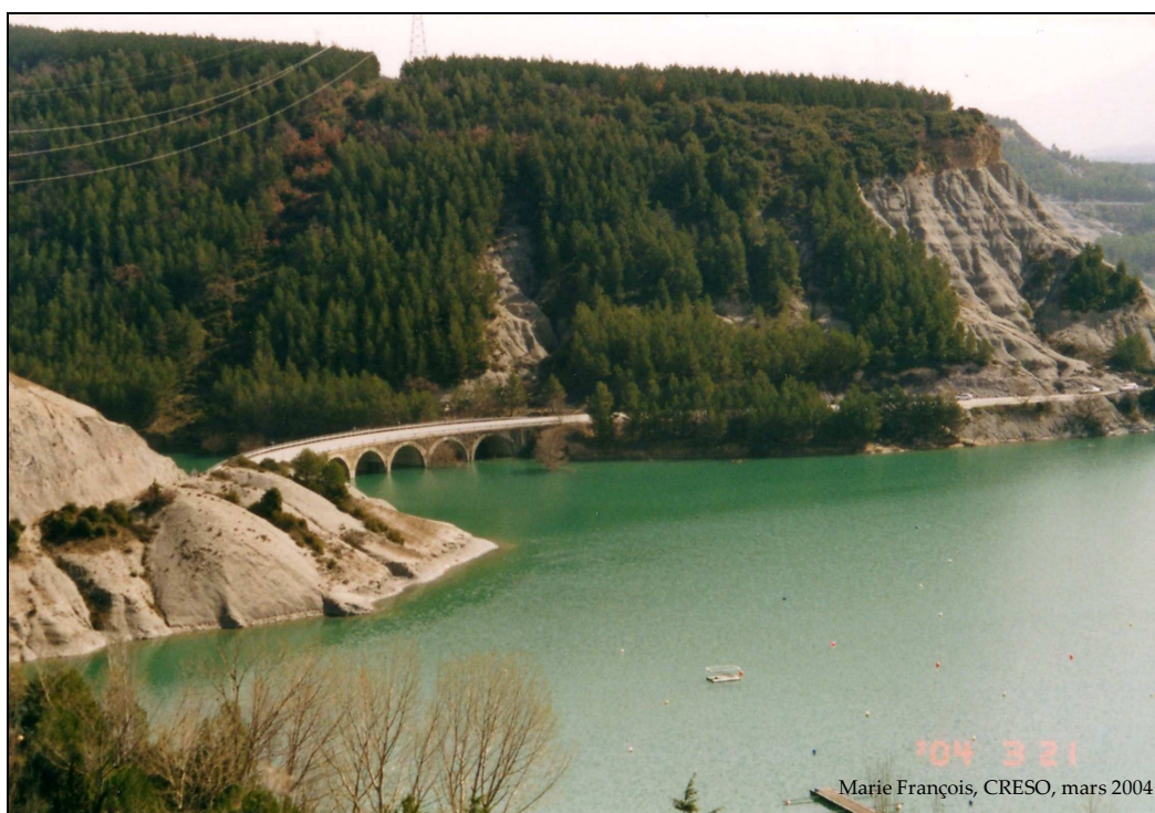
Photographie n°11. Vue du lac de barrage de Yesa (mars 2004)
