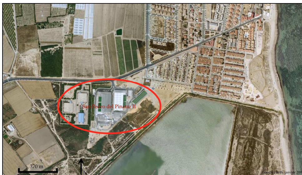
Photographie n°21. Vue aérienne de l'usine de San Pedro del Pinatar (2007)
