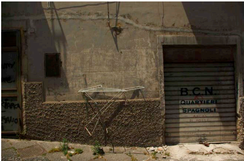
Fig. 2.26. Étendoir à linge rangé contre le mur en surélévation
