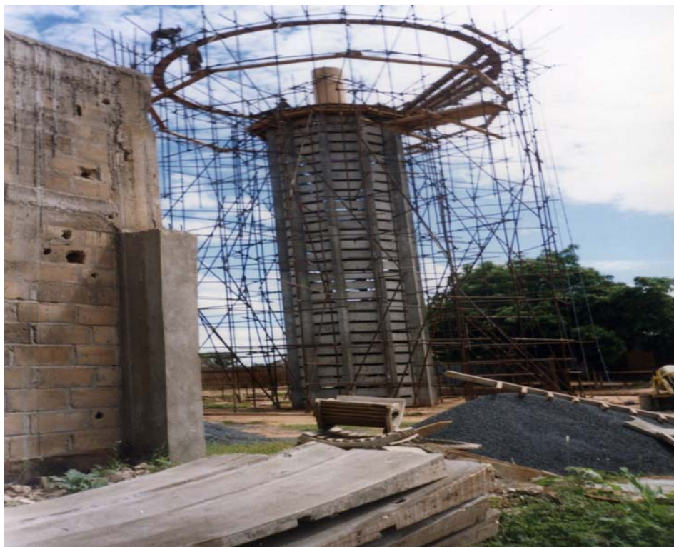
Photo 28. La construction du forage de Mbeuleukhé en 2001
