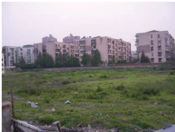
Cliché 9 - Shanghai, au-delà du périphérique extérieur : terrain laissé inutilisé dans l'attente d'une cession publique pour être ensuite construit, Liu K.
