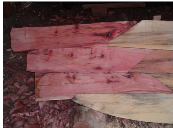
Photographie 76 : Assemblage entre quille et galbord
