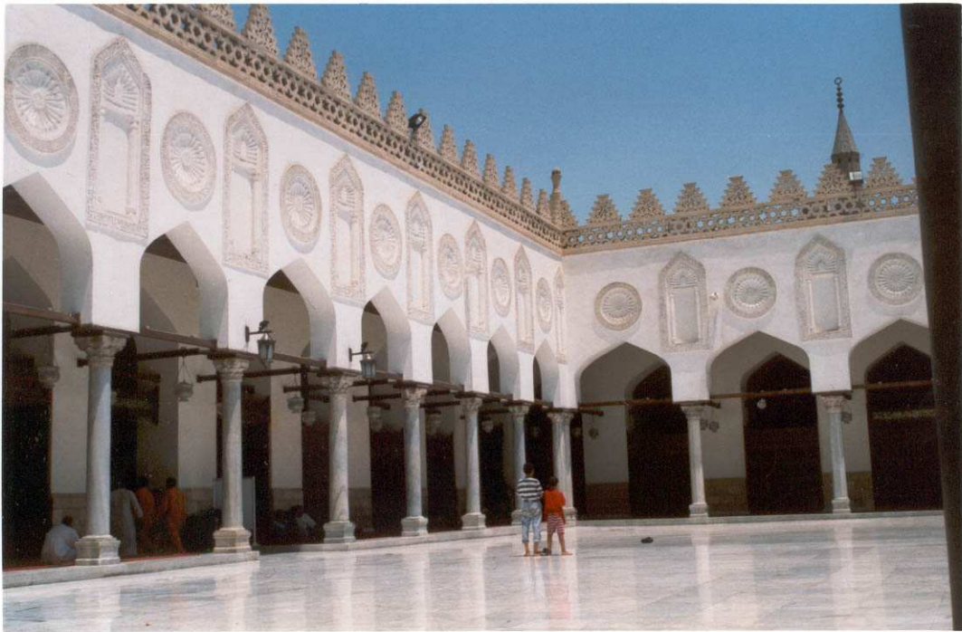
Photo 4-24: Vue de l'intérieur de la mosquée al-Azhar. L'ensemble restauré présente quasiment le même point de vue que la photo de 1870. 1999. ES.
