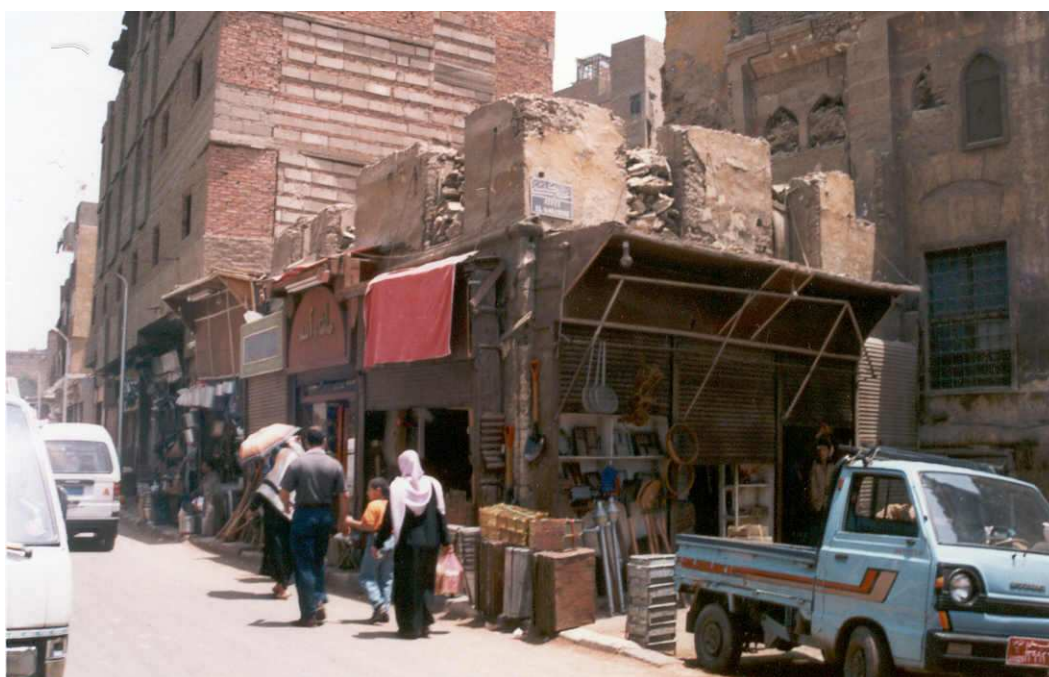
Photo 1-17 : Dans une rue commerçante de la vieille ville (proche de Bab Zuwayla). L'étage supérieur de la boutique est détruit. L'édifice de briques rouges en arrière-plan est un immeuble de construction récente. A droite, derrière la camionnette bleue, un édifice classé en très mauvais état. ES, 1998.
