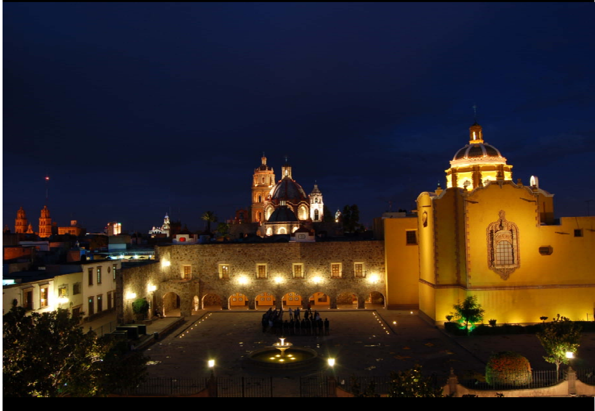
LA ILUMINACIÓN del Conjunto de la Plaza de Aranzazú
