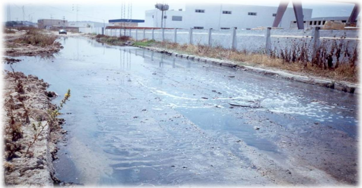
Photo n°34 : Ampleur des eaux usées stagnantes dans la zone industrielle d'Utique (BOUCHOUICHA S., 2004)
