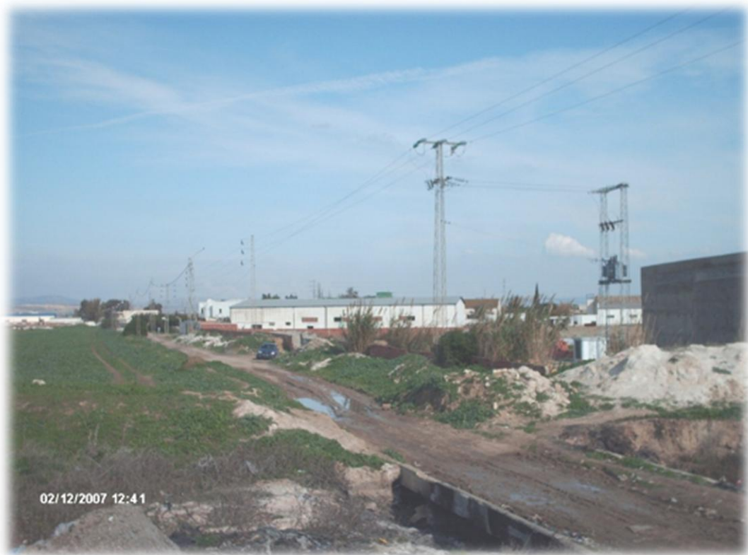
Photo n°29 : Les différentes usines dominant la partie Ouest de la zone industrielle d'Utique.
