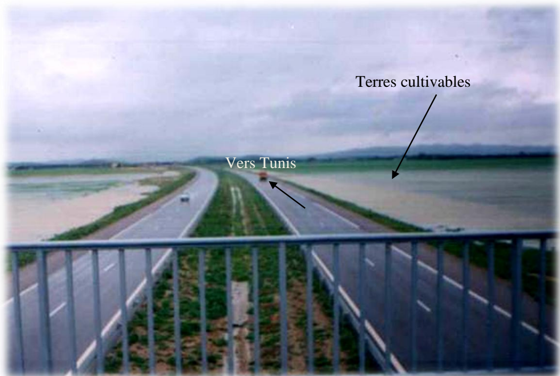
Photo n°12 : L'effet barrage de l'autoroute favorise l'extension des crues vers le Sud de garaât El Mabtouha au dépens des terrains cultivables.
