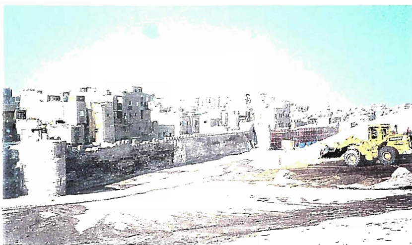
Figure 88 : Travaux à côté du mur de Saladin dans le jardin Al-Azhar, Le Caire.
