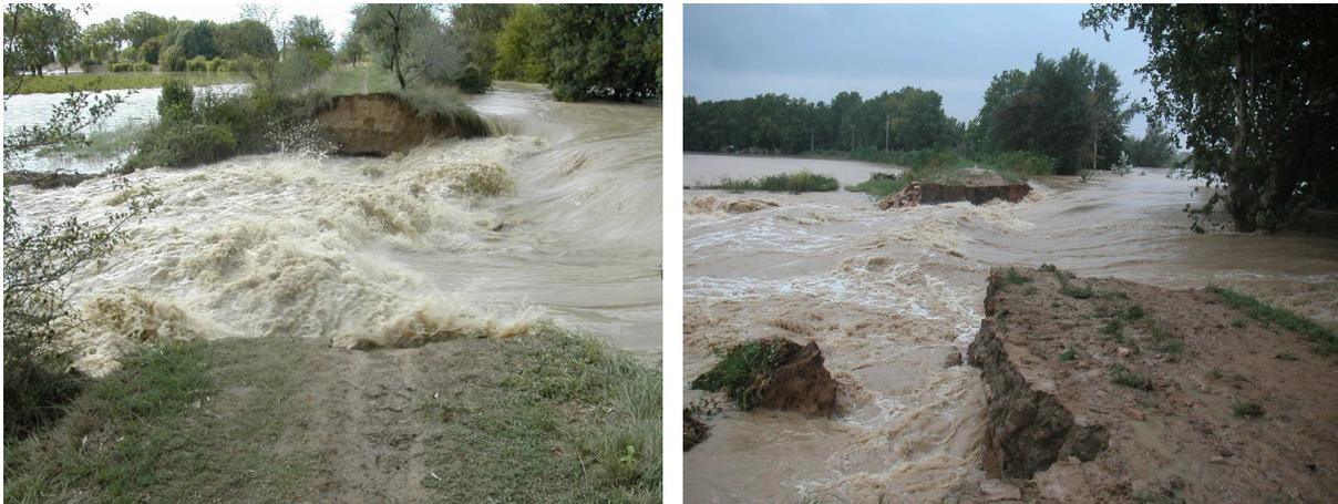
Figure 10. Cas de rupture par surverse sur le Vidourle, Gard, 2002 (Source Cemagref)
