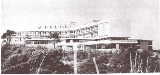
Vue du bâtiment depuis l'extérieur
