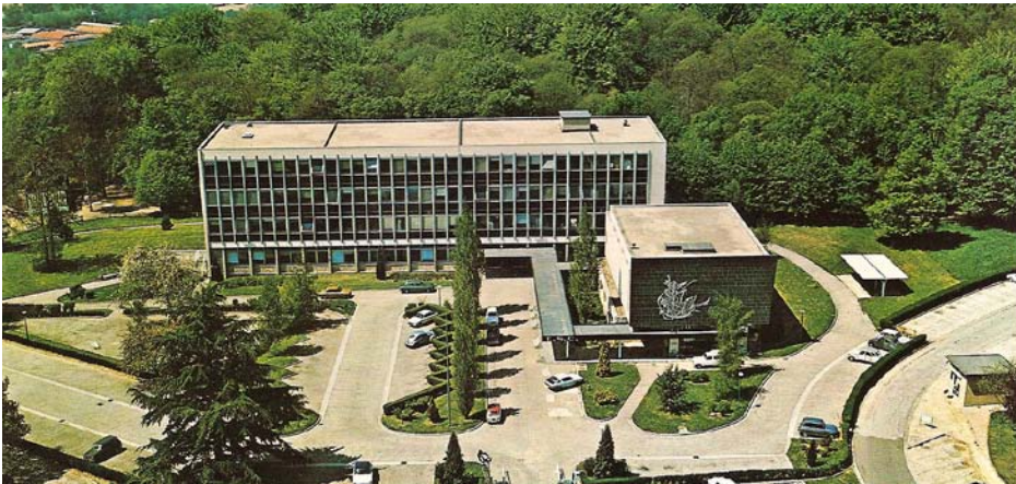
Vue du bâtiment depuis l'extérieur
