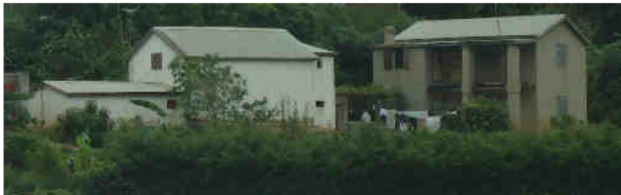
Photo n° 6 : Nouvelle construction semi-moderne (exemple à Ambohimangakely)
