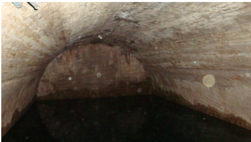
Fig. 17 : La réserve d'eau du fort de San Diego. Collection personnelle.
