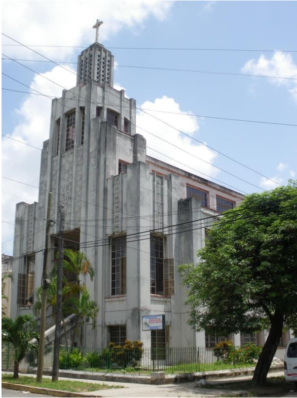
Figure 16 : Église Méthodiste (1951), Vedado.
