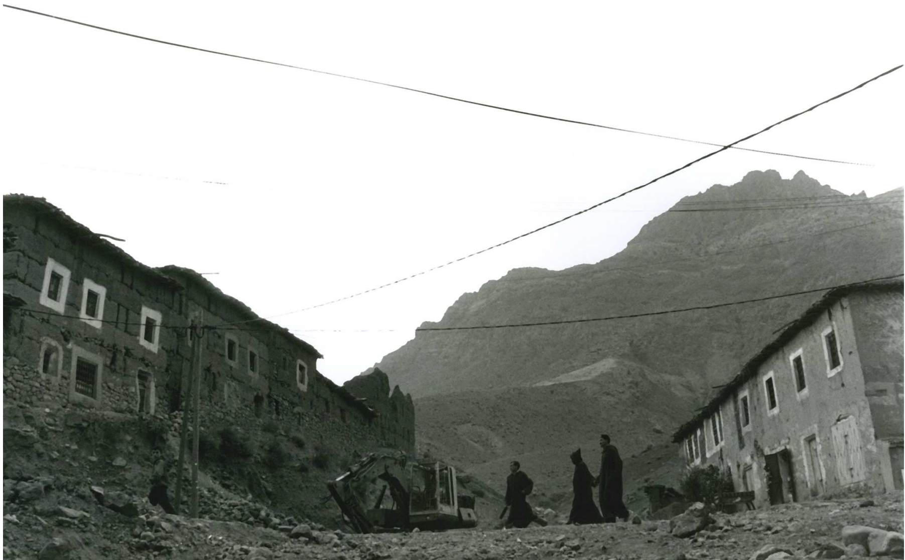
Le désenclavement de la vallée des Aït Bou Oulli : bulldozer et fils électriques rencontrent les maisons en pisée — photographie : Rupert Sharpe, 2008
