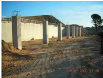
Voile béton et poteaux, Janvier 2008
