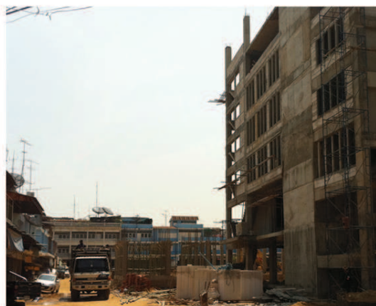
Chantier du nouveau centre commercial, à l'ouest de la rue principale et à proximité du poste-frontière (2011). Investisseur privé national
