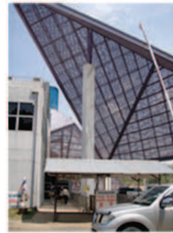
Poste-frontière de Chong Mek (province d'Ubon Ratchathani) après sa rénovation (2010)
