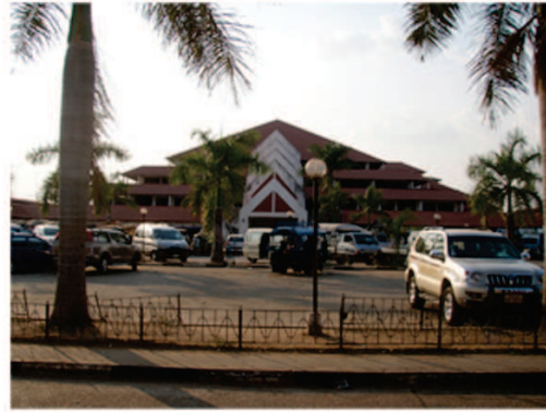
Bâtiment du marché Savanxay (2009)
