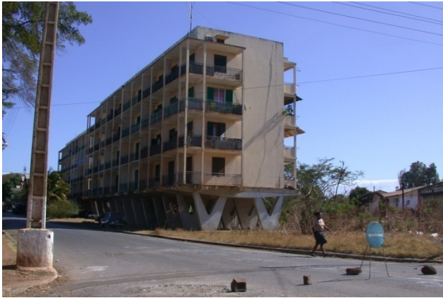
Photographie 49 : Les Quatre Etages, 2002
