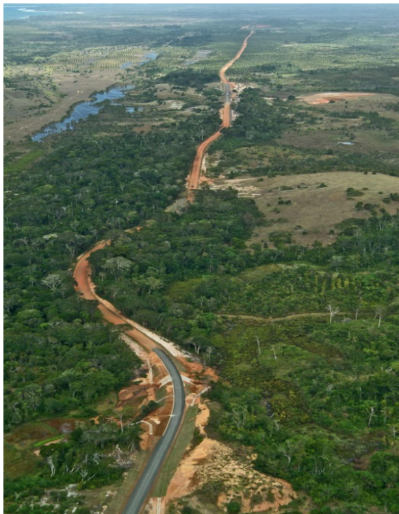
Photographie 35 : Vue aérienne de la construction de la route Sambava – Antalaha, 2006
