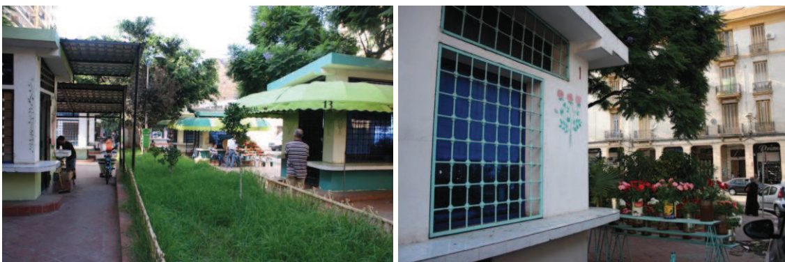
B) Kiosques et massifs encombrant l'espace
