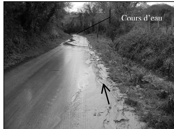
Figure 92. Canalisation et circulation des écoulements de surface sur la voirie
