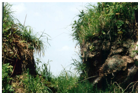
Figure 81. Brèche dans un talus pour l'évacuation des eaux : sous-bassin versant du Sterenn (Bocher, 2003)
