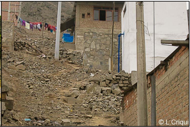
Photo 40/L. Réservoir inaccessible alimenté par pompe (Lima, Comas, Collique, 26/07/2012)
