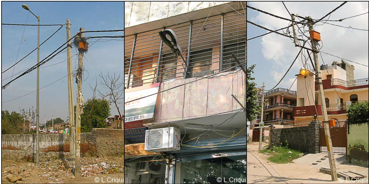
Photo 74/D. Poteaux juxtaposés (Delhi, Vinod Nagar, 27/01/2013)
