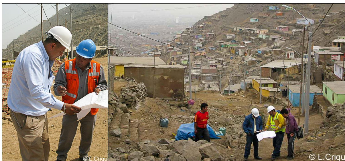
Photo 90/L. Ingénieur et chef de chantier (Lima, Huarochirí, Jicamarca, 16/05/2012)
