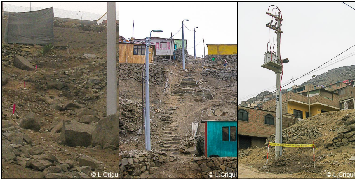
Photo 71/L. Bornes de délimitation Photo 72/L. Tracé du futur escalier Photo 73/L. Station surélevée (Lima, Comas, Collique, 16/08/2012)
