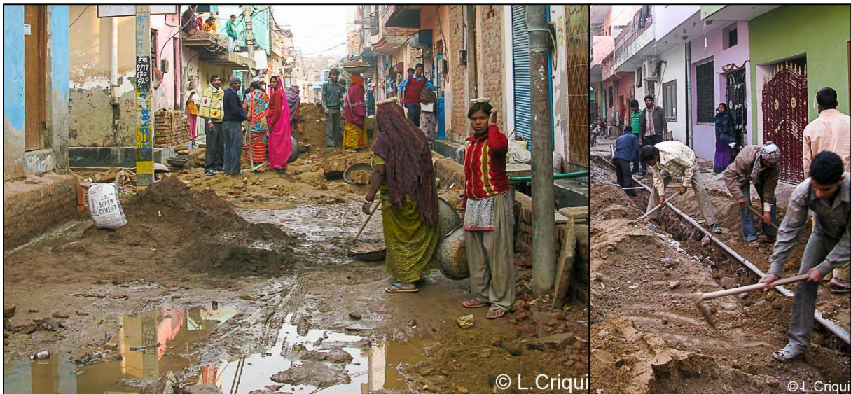
Photo 29/D. Équipe d'ouvriers sur un chantier (Delhi, Prem Nagar, 31/01/2013)
