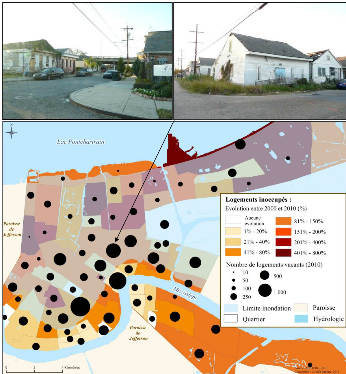
Figure 107 : Forte augmentation du nombre de constructions vacantes délabrées dans le quartier du Seventh Ward qui se caractérise par des paysages urbains dégradés (Clichés de l’auteur, 2011).
