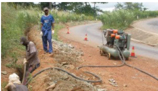
Illustration 11: Installation du câble (fibre optique) entre Matadi et Kinshasa.
