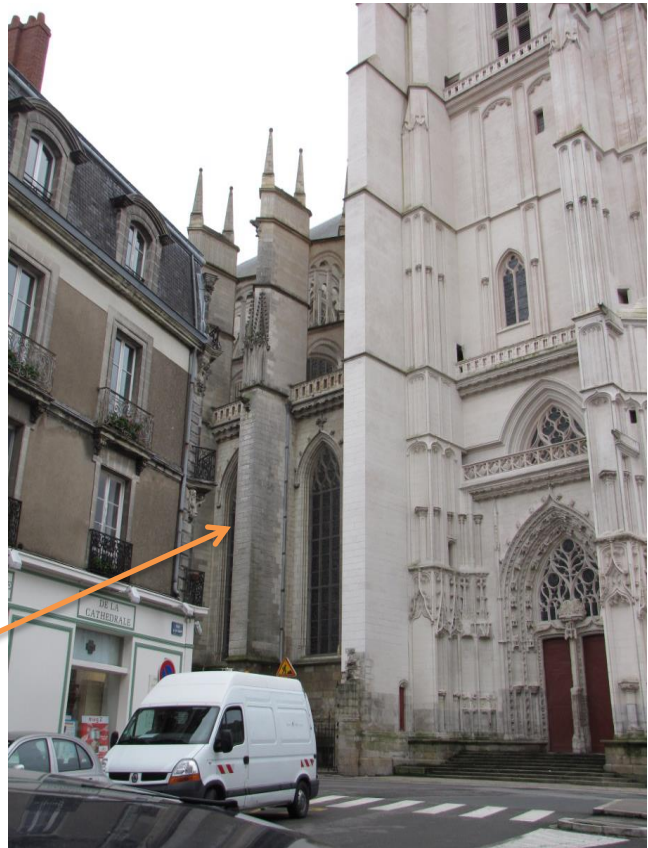
Figure 19 : Vue sur les arcs-boutants de la cathédrale de Nantes (Photographie de l'auteur, le 10/01/2012)
