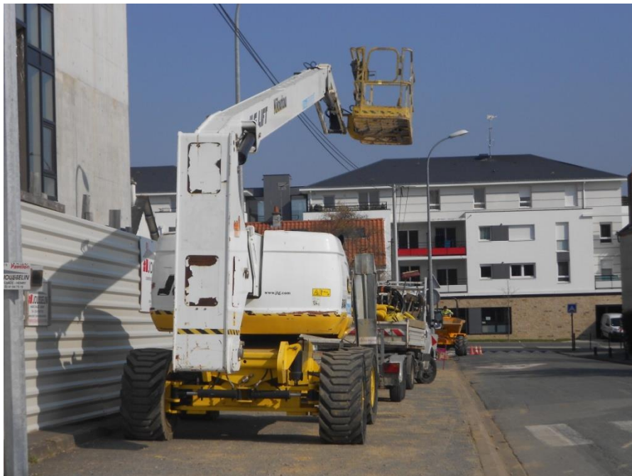
Figure 93 : Espace aménagé avec l'intervention d'engins de chantier (Photographie de l'auteur, le 3/04/2013)
