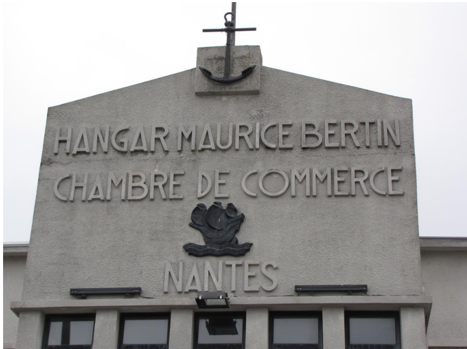
Figure 56 : La façade du hangar à bananes (Photographie de l'auteur, le 21/05/2012)
