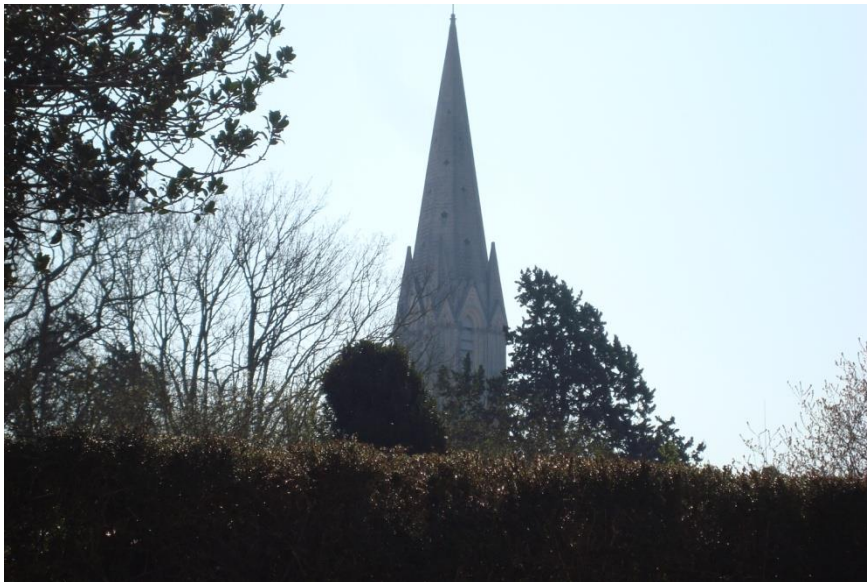
Figure 102 : Le clocher de l'église au niveau de la station n°3 (Photographie de l'auteur, le 3/04/2013)
