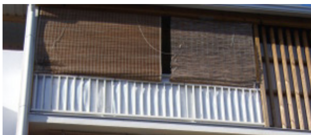
Figure 168 (PHOTO) : Obturation de certaines terrasses par les habitants, limitant de ce fait la capacité d'auto-régulation de la chaleur (Opération Aldabra)
