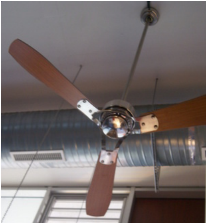
Figure 134 (PHOTO) : Brasseurs d'air pour maximiser le confort des usagers. (Opération Ilet du centre, Bureaux)
