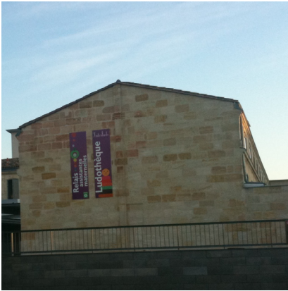
Figure 16 (PHOTO) : Ludothèque, espaces pour enfants, salle polyvalente à disposition dans le quartier (Cœur de Bastille)
