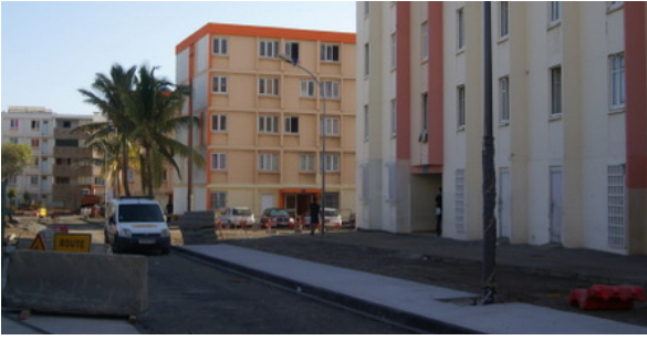
Figure 249 (PHOTO): Rétrécissement des voies, création de trottoirs (Ravine Blanche)
