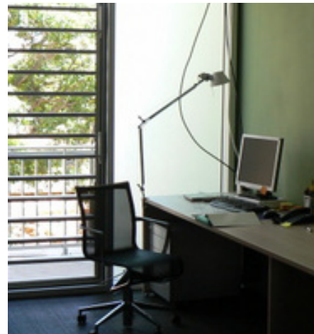
Figure 136 (PHOTO) : Des ouvertures persiennées modulables disposées sur toute la hauteur sol/plafond permettent de maximiser l'entrée de ventilation (Opération Ilet du centre, Bureaux)
