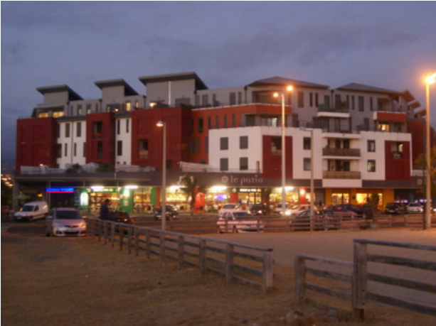
Figure 194 (PHOTO) : Opération privée localisée en front de mer, en face terrain de beach-volley. Elle y accueille des commerces en rez de chaussée (Opération Le Patio, Ravine Blanche)
