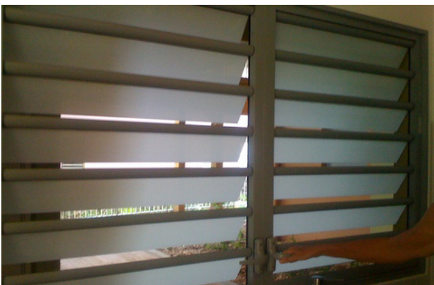
Figure 138 (PHOTO) : Ouvertures persiennées réglables et sécurisées pour alimenter constamment le logement en fraîcheur (Opération Le Belvédère)
