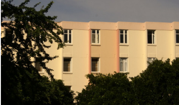
Figure 211 (PHOTO) : Des logements collectifs non équipés de protections solaires ni de varangues
