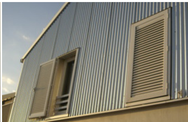
Figure 139 (PHOTO) : Volets persiennés pour ventiler et protéger du rayonnement solaire. Les couleurs claires permettent de diminuer la captation de chaleur par la structure du bâti (Opération Aldabra)
