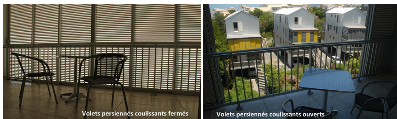
Figure 166 (PHOTO): Volets persiennés coulissants pour moduler l'ambiance thermique de la terrasse (Opération Ilet du centre) (EMMANUEL DINH)
