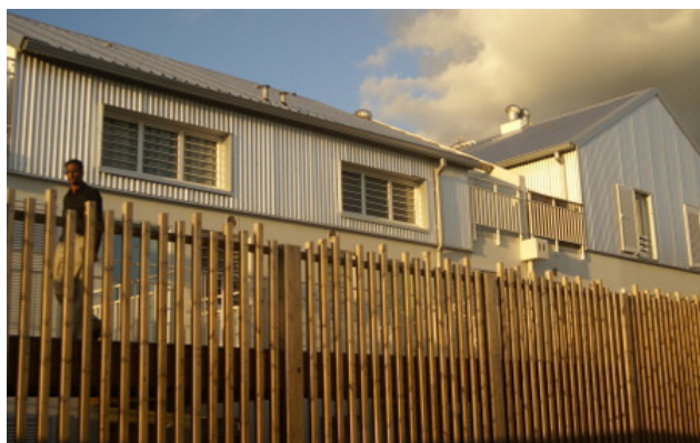
Figure 129 (PHOTO) : Exemple de coursives extérieures au bâti (Opération Aldabra)
