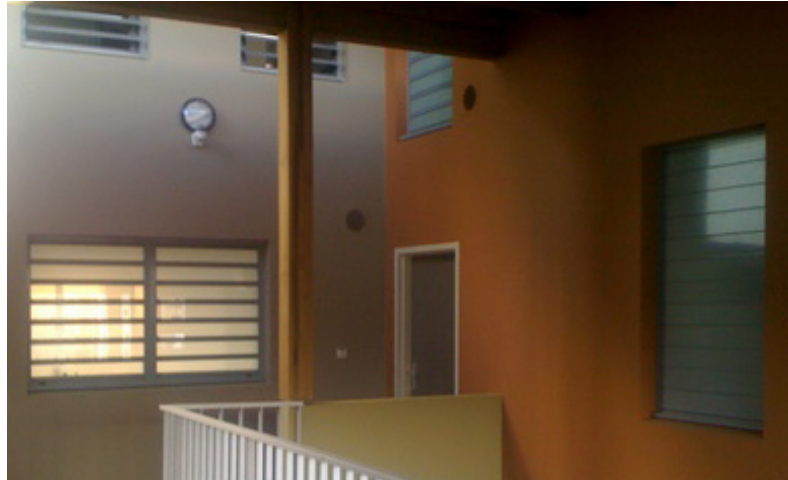
Figure 135 (PHOTO) : Nombreux ouvrants favorisant la circulation de l'air. (Opération Le Belvédère)
