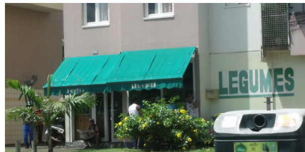
Figure 214 (PHOTO) : Quelques rares commerces en pied d'immeubles
