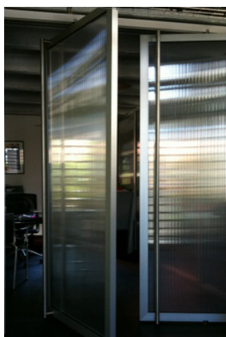
Figure 132 (PHOTO) : Portes intérieures orientables, intégrant toute la hauteur sous plafond et permettant de ventiler selon le souhait la pièce. (Opération Ilet du centre, bureaux)
