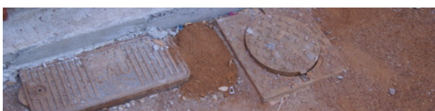
Figure 257 (PHOTO) : Chaque maison en bande individuelle fait l'objet de raccordements individualisés au réseau (Ravine Blanche)
