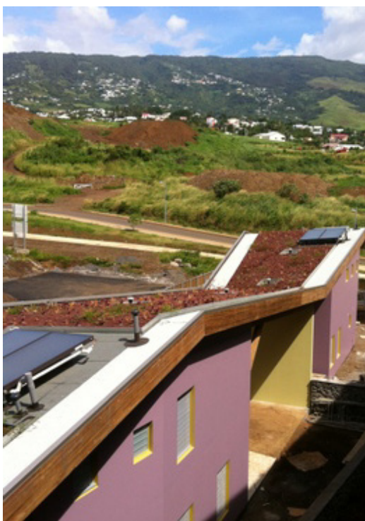
Figure 143 (PHOTO): Toiture végétalisée (Opération Le Belvédère)
