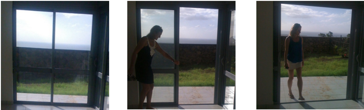
Figure 137 (PHOTO): Baies à galandage pouvant s'ouvrir à 100 % ou être réglées en fonction du confort recherché et selon les conditions climatiques (Opération Le Belvédère)
