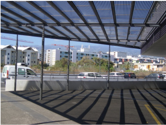
Figure 295 (PHOTO) : Espace d'attente ombragé au Patio
