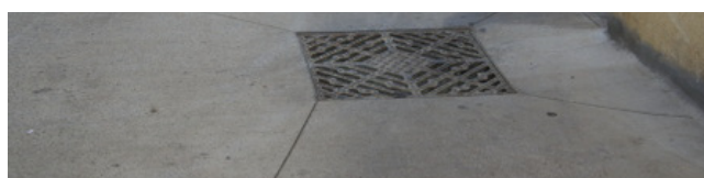
Figure 258 (PHOTO) : Pentes d'écoulement des eaux pluviales (Ravine Blanche)
