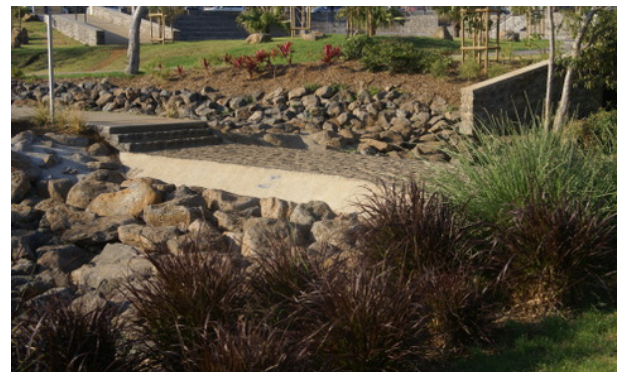
Figure 248 (PHOTO) : Gestion des eaux pluviales du canal Sorema (Ravine Blanche)
