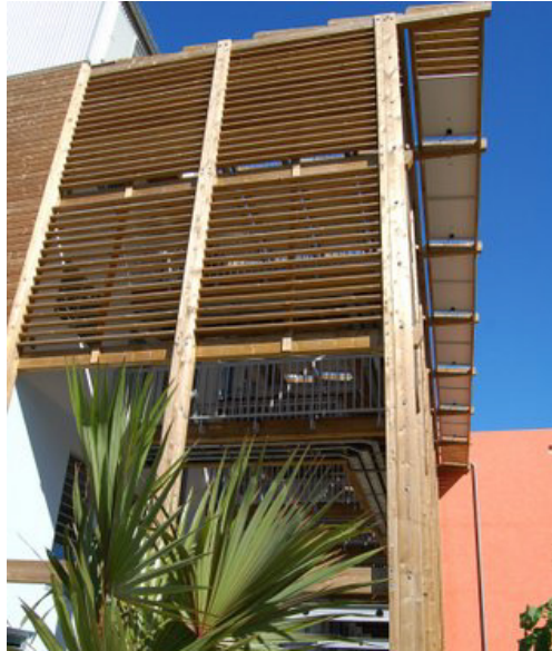
Figure 122 (PHOTO) : Protection solaire du bâtiment (Opération Aldabra, Saint-Pierre)
