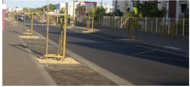
Figure 250 (PHOTO): Rue Mahatma Gandhi après rénovation urbaine. (Ravine Blanche)
