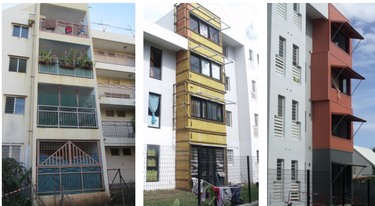
Figure 240 (PHOTOS) : Des terrasses isolées thermiquement, puis transformées en pièce à vivre lors de la réhabilitation des immeubles existants, création de pare-soleil, résidentialisation du jardin (Ravine Blanche)
