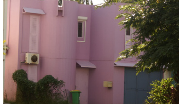
Figure 212 (PHOTO) : Des logements équipés parfois de climatisations
