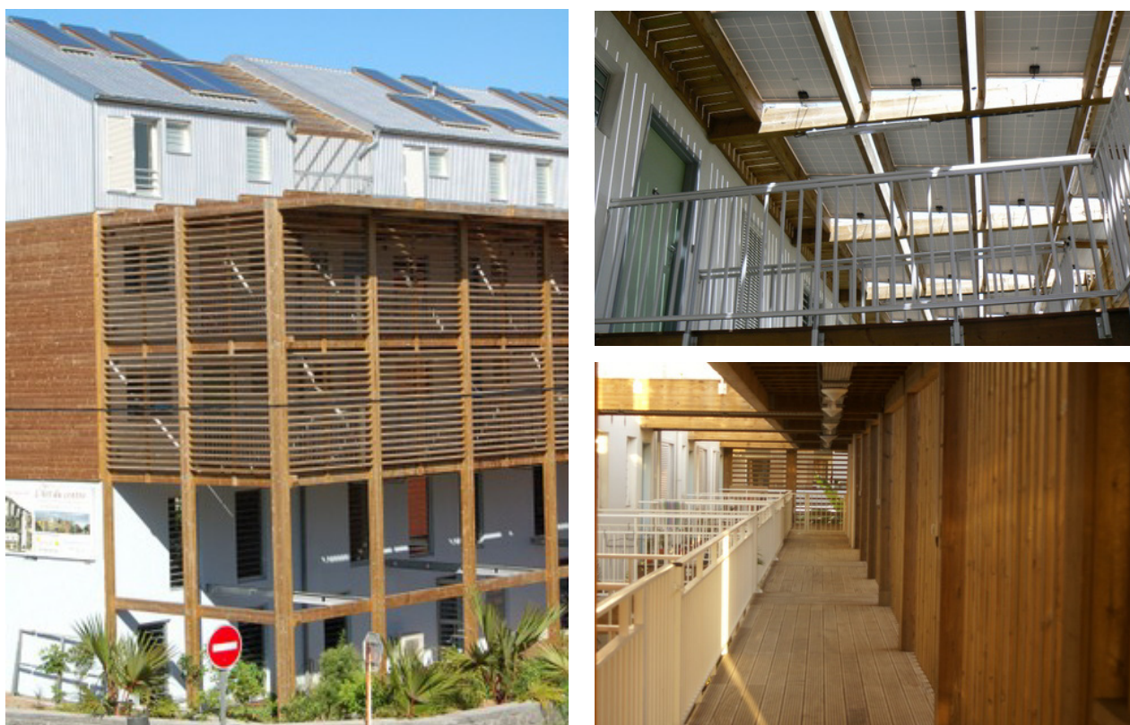
Figure 155 (PHOTOS) : Une structure en bois enveloppante abrite les coursives aériennes menant aux logements et le bâti. Des pare-soleil en bois verticaux horizontaux servent en effet de pare-soleil poreux aux vents. Au dernier étage, des panneaux photovoltaïques protègent horizontalement du soleil (Opération Ilet du centre à gauche (LEU REUNION) . En bas à droite (DOURIS POUR LEU REUNION) ; Aldabra à droite)
