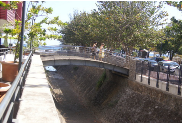
Figure 261 (PHOTO) : Canal Sorema au niveau du Patio (Ravine Blanche)
