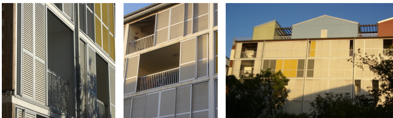
Figure 165 (PHOTOS) : Varangues équipées de panneaux persiennés coulissants (Opération Ilet du centre)
