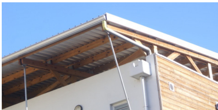
Figure 144 (PHOTO) : Sur-toiture (Opération Aldabra)
