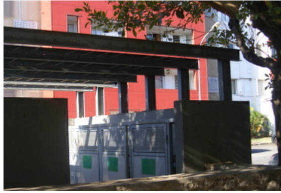
Figure 315 (PHOTO): Espace de poubelles ombragé dans une opération réhabilitée
