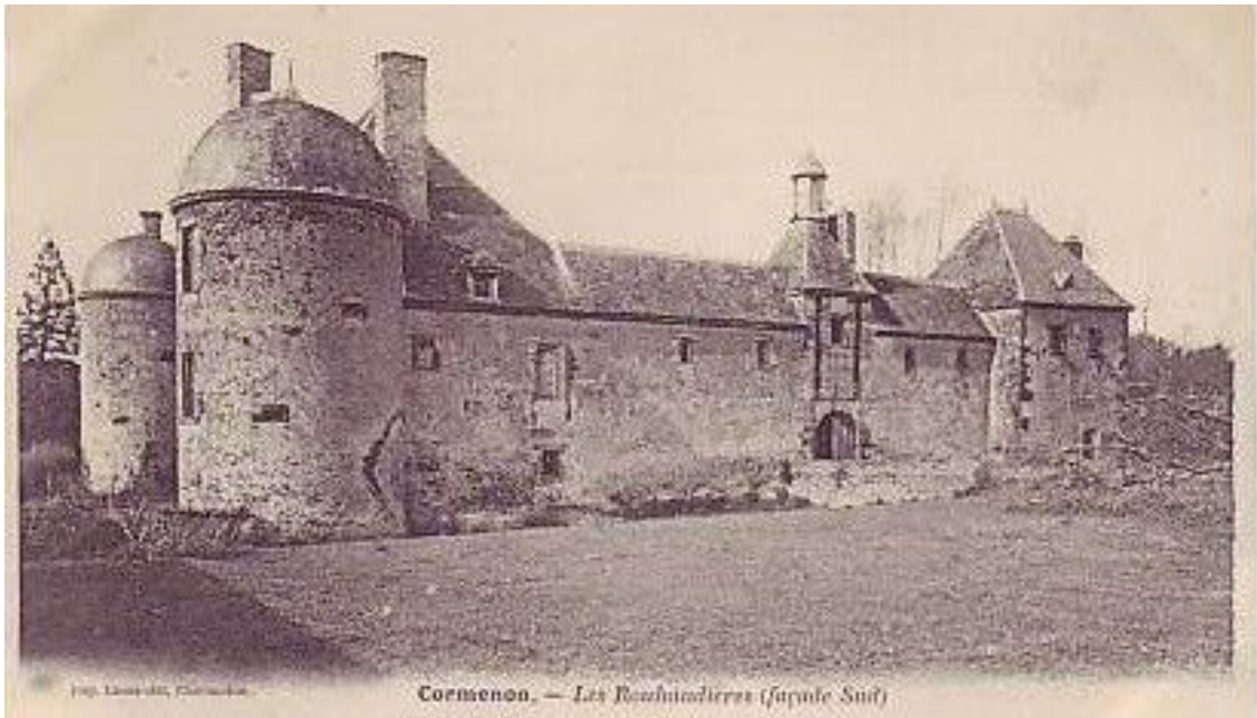
L'entrée du château, façade sud. Il ne reste aujourd'hui qu'un pan du mur de la façade ouest.
