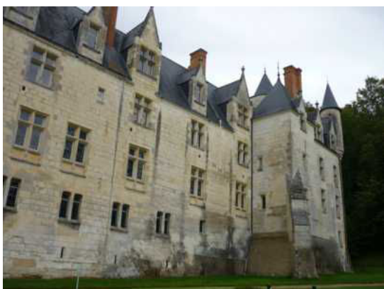
Une aile du château de Courtanvaux
