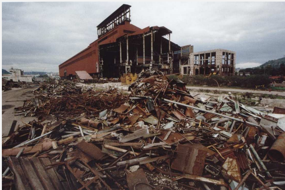
Photographie 4.5 Bagnoli : de l'aciérie au patrimoine industriel
