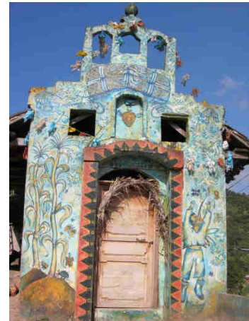
Figure 10 - Église de l'entrée de San Pedro Polhó (Source : donnée de terrain, novembre 2008)
